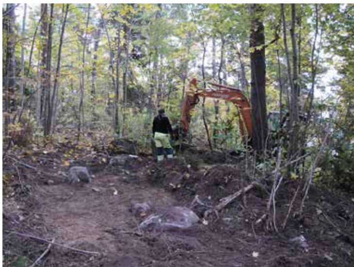
Fig 5. Schakt 235 tas upp. Från väster. Bild nr LP 2013_00040.
