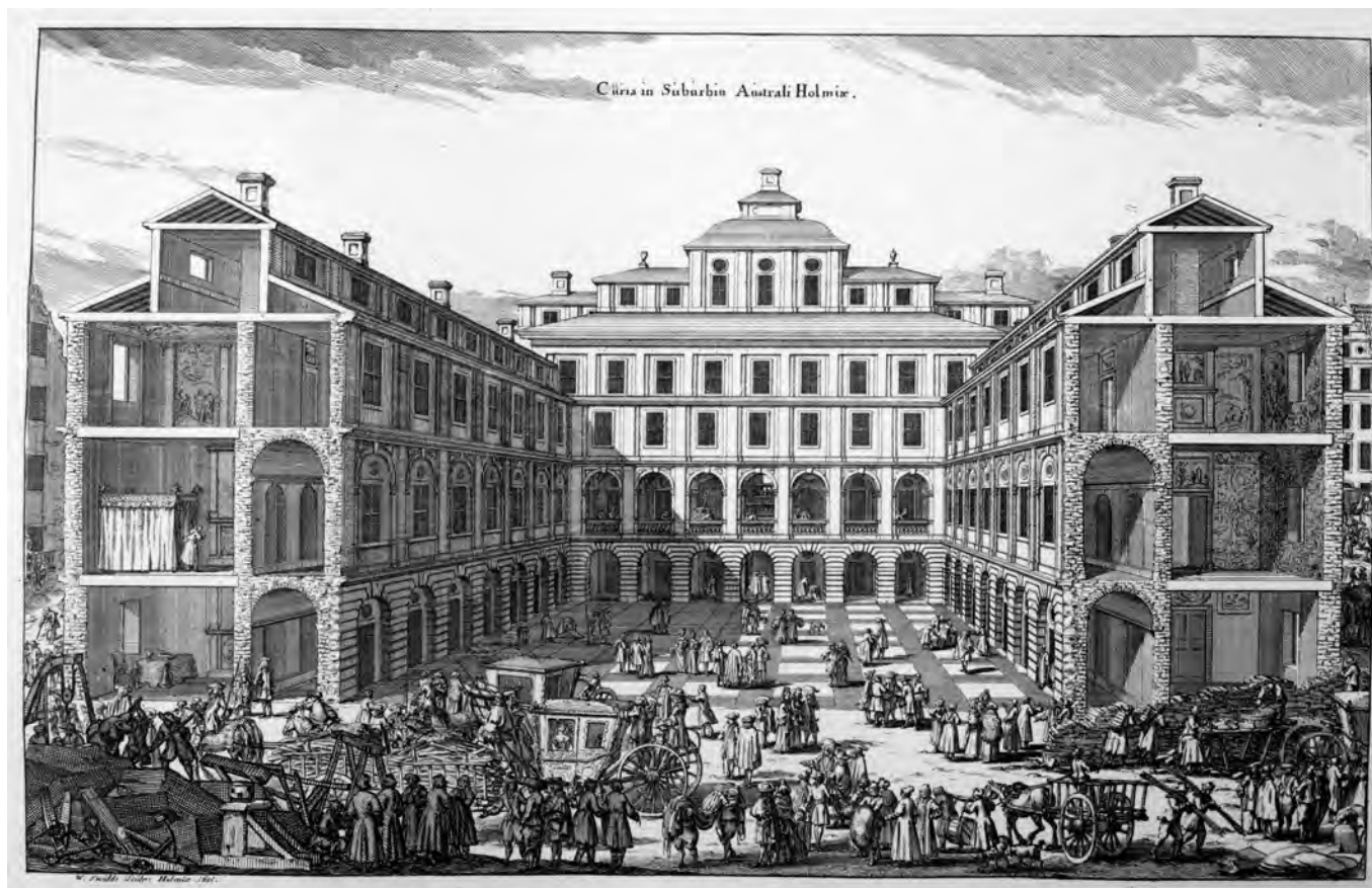
Huset är nästan färdigbyggt, solen skiner. På gården vandrar söderbor omkring, både män och kvinnor, rika och fattiga. Där är järnbärare, murare, mursmäckor, ryska köpmän, vindragare, fina damer och pigor.
