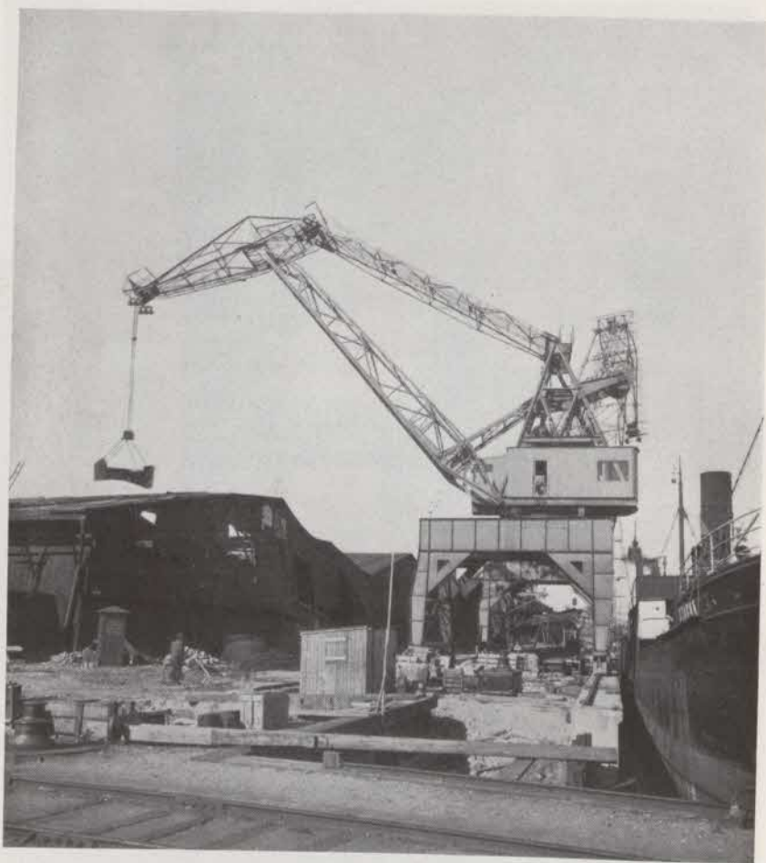
Vipparmskran med 25 m svängradie i Norra Värtahamnen.
