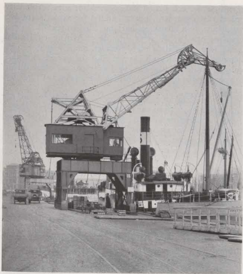
Vipparmskranar med 15 m svängradie i Skeppsbrohamnen.
