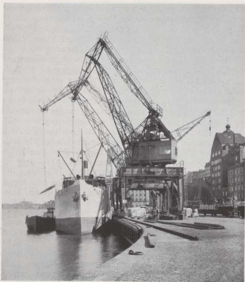
Vipparmskranar med 23,5 m svängradie i inre Stadsgården.
