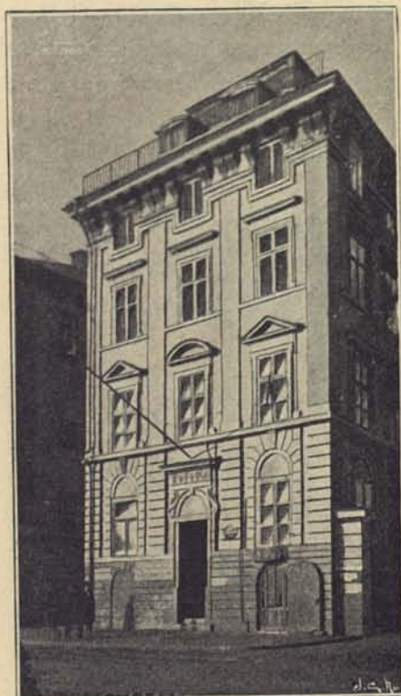
A. R. fot. 139. Skeppsbron n:r 40.
