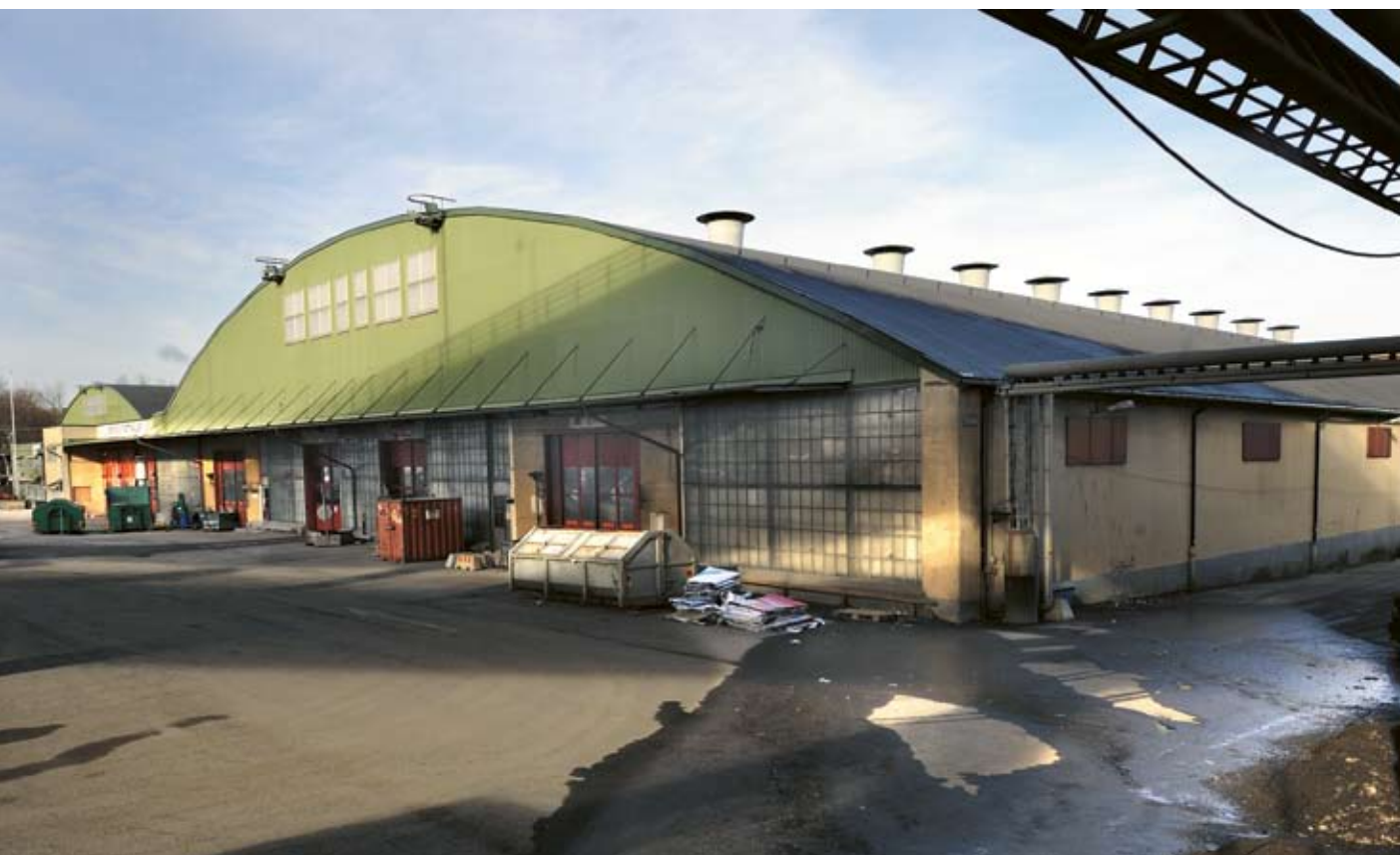
Det norra garagets sydöstra gavel. Foto Tomasz Pydzik 2009. SSM DIG 002018.
