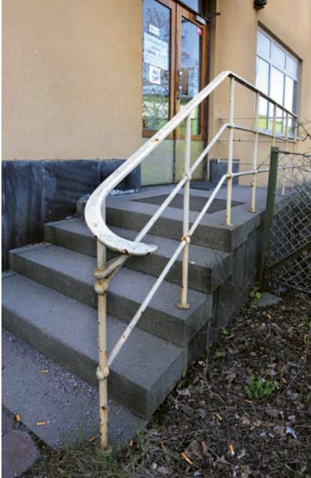
Entrétrappa och dörr till den före detta personalmat-salen. Foto Tomasz Pydzik 2009. SSM DIG 002045.
