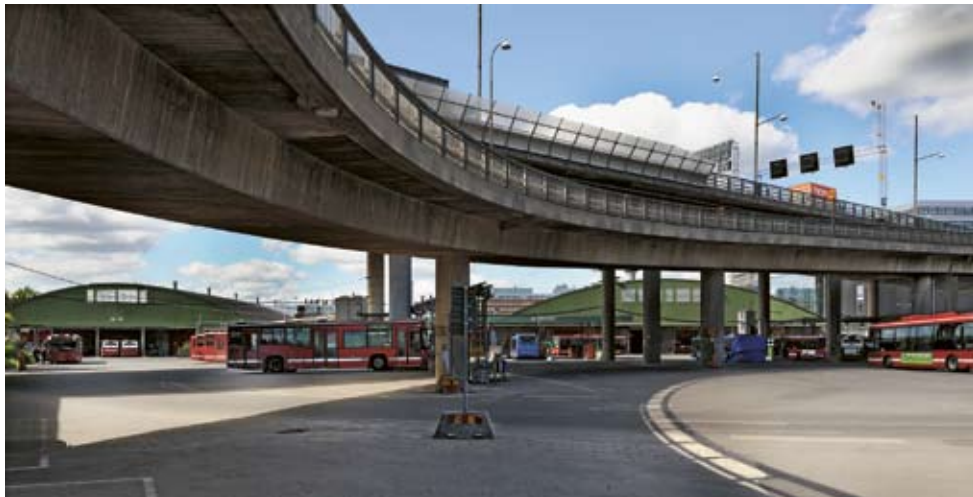
Södra respektive norra garagehallen mot nordväst. Essingeleden skär sedan 1966 rakt genom området. Foto Tomasz Pydzik 2009. SSM DIG 002004.
