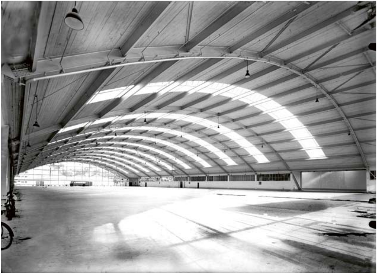
Det södra bussgaragets interiör. Foto Karl Wallberg, sannolikt taget på 1930-talet, Spårvägmuseet.
