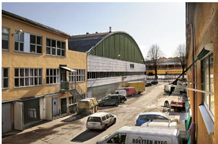
Det södra bussgaragens nordvästra fasad idag. På fotot syns även tvätthallens nordvästra fasad. Foto Tomasz Pydzik 2009. SSM DIG 002005.
