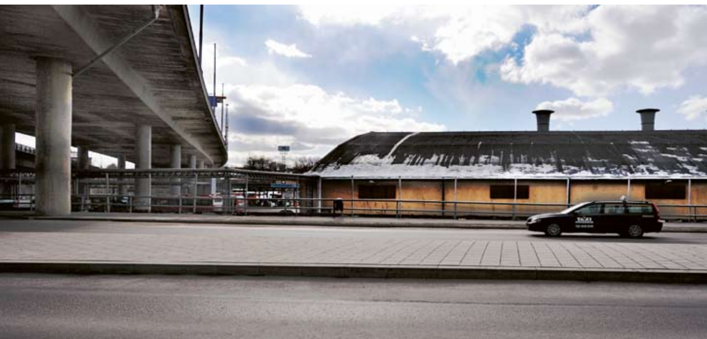
Det norra bussgaraget sett från Lindhagensgatan, foto mot söder. Essingeleden, till vänster i bild, skär sedan mitten av 1960-talet över området för Hornsbergs bussdepå. I fonden skymtar klocktornet och etanolstationen. Foto Tomasz Pydzik 2009. SSM DIG 002021.
