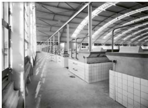
Hornsberg, interiör från den södra garagehallen. De kakelklädda revisionsgroparna är idag överdäckade. Foto Karl Wallberg, sannolikt taget på 1930-talet, Spårvägmuseet.
