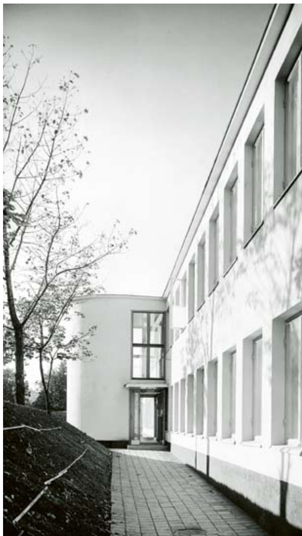
Kontorsbyggnadens södra fasad med det centralt placerade och utskjutande trapphuset. Foto Carl Gustav Rosenberg 1932, Spårvägmuseet.
