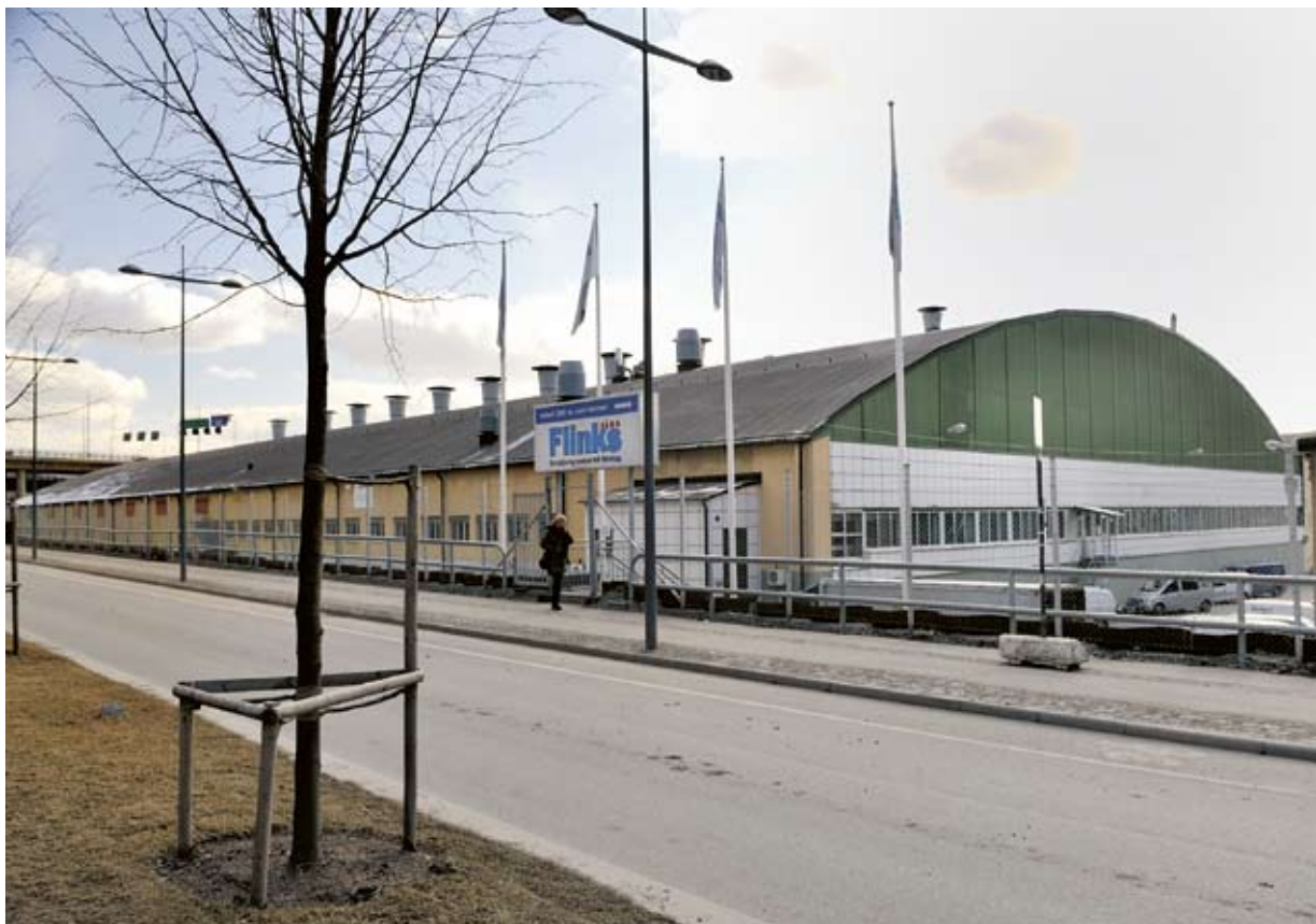
Det norra bussgaraget sett från Lindhagensgatan. Foto mot sydost, Tomasz Pydzik 2009. SSM DIG 002017.
