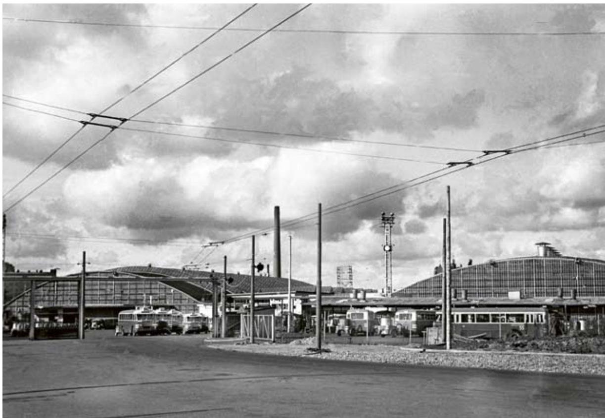
Hornsbergs bussgarage med mellanliggande tvätthallar, sydöstra fasaden. Foto Börje Gallén 1944, Spårvägmuseet.
