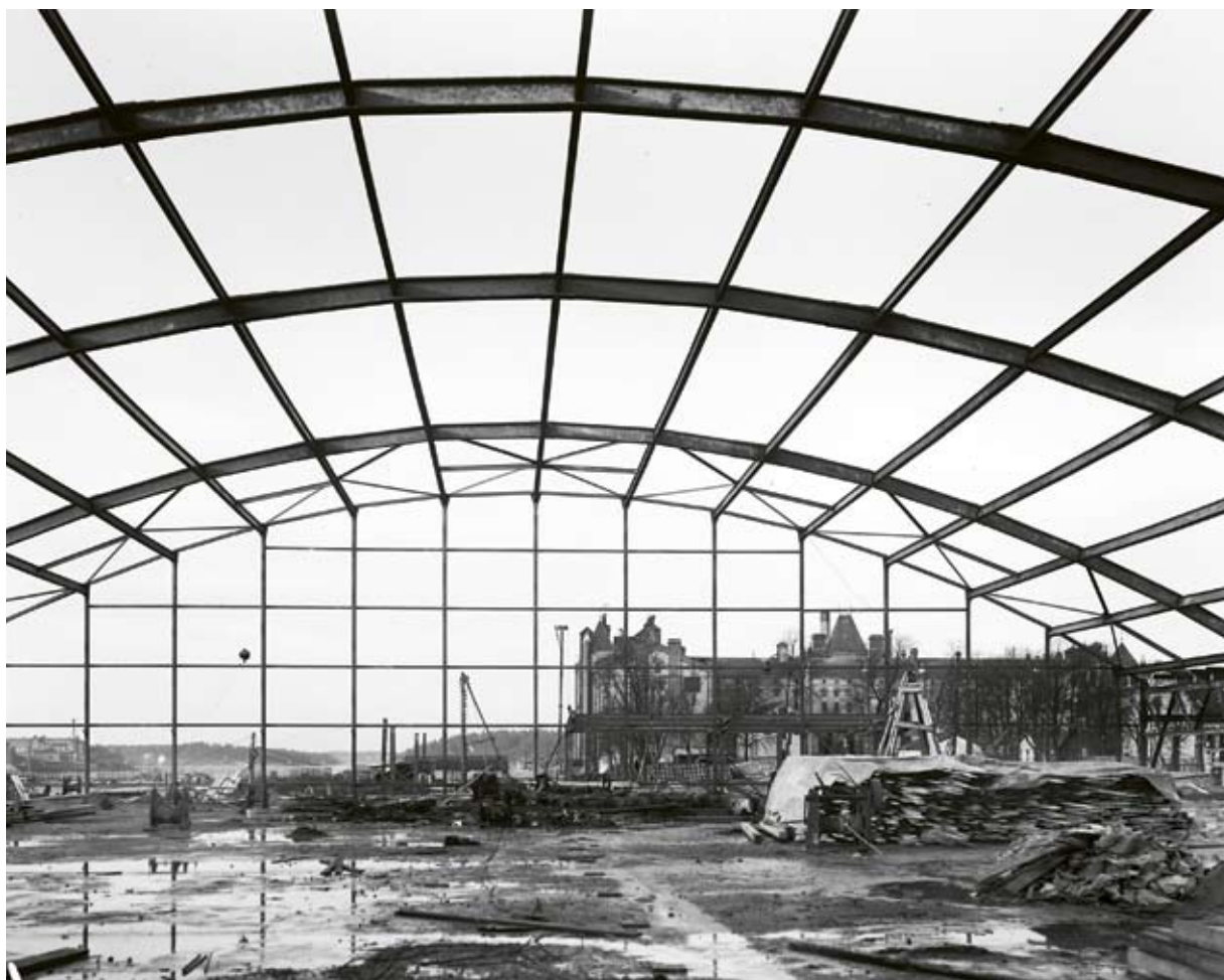
Hornsbergs bussgarage under uppförande. Foto 1932, fotograf okänd, Spårvägmuseet.
