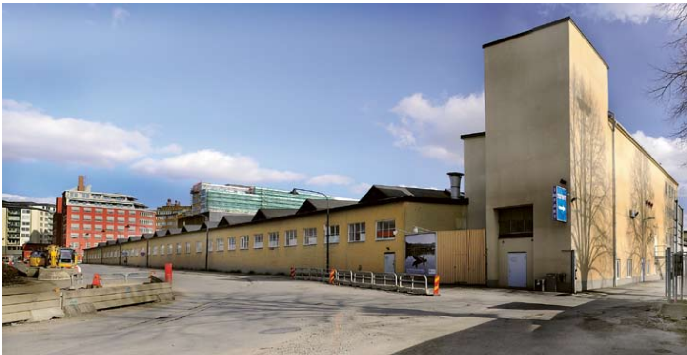
Verkstadsbyggnaden och värmecentralen, foto mot nordost. Foto Tomasz Pydzik 2009. SSM DIG 002010.
