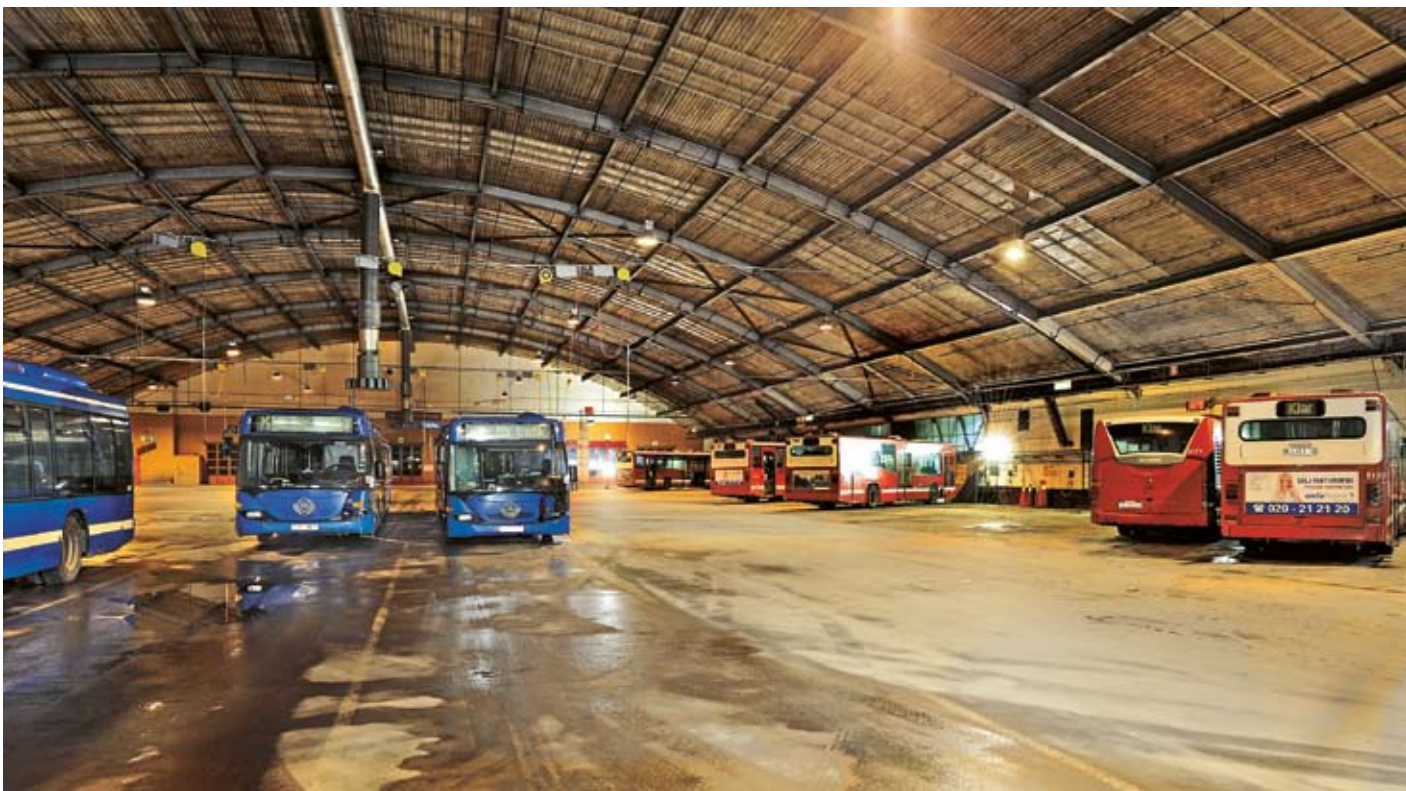
Det södra bussgaragets interiör idag. Foto Tomasz Pydzik 2009.SSM DIG 002006.
