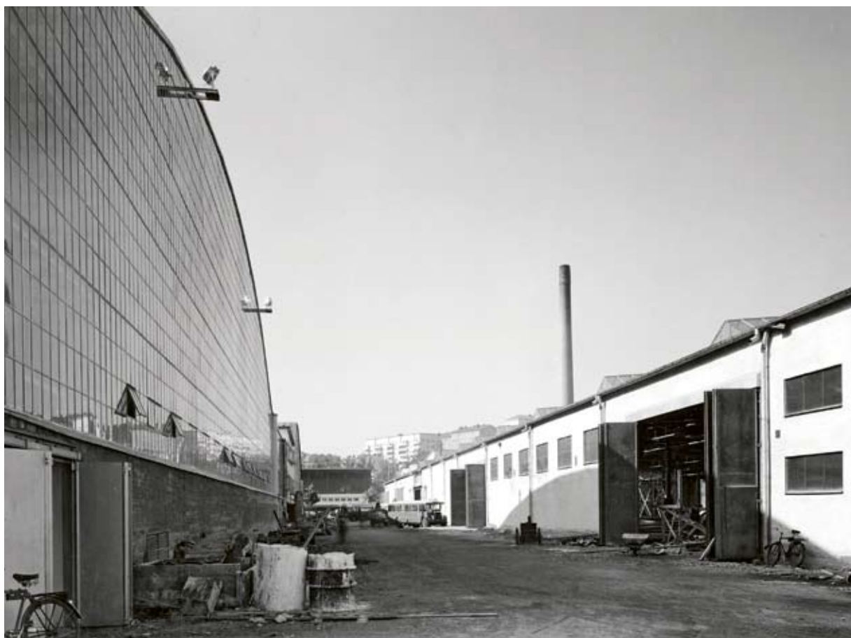
Det norra garagets nordvästra gavel samt verkstadsbyggnaden. Foto Carl Gustav Rosenberg, cirka 1940, Spårvägmuseet.
