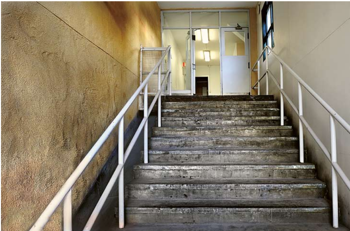
Trapphall i omklädningsbyggnaden, foto mot öster. Foto Tomasz Pydzik 2009. SSM DIG 002040.
