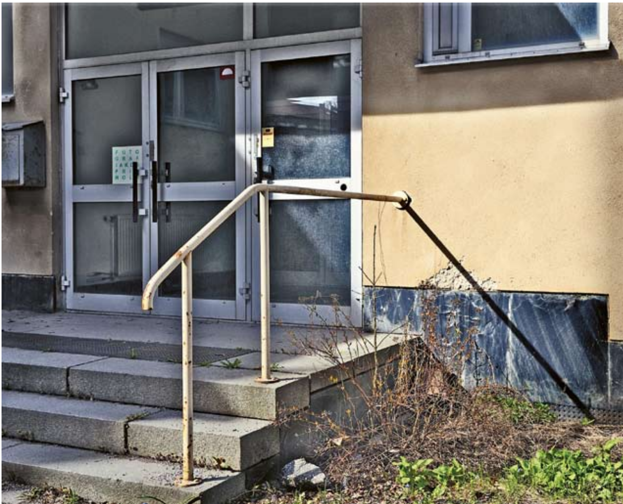
Entrédörren till samlingsalen och den före detta caféavdelningen. Foto Tomasz Pydzik 2009. SSM DIG 002044.
