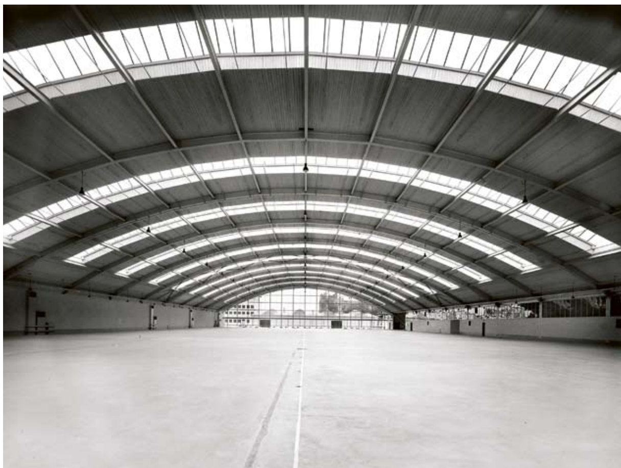
Hornsberg, interiör från det södra bussgaraget. Foto Karl Wallberg, sannolikt taget på 1930-talet, Spårvägmuseet.
