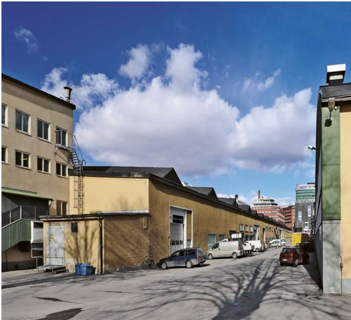
Värmecentralen samt verkstadsbyggnaden, foto mot norr. Foto Tomasz Pydzik 2009. SSM DIG 002037.
