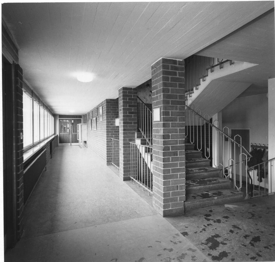
S92-0178-8 Korridor och trapphus.
