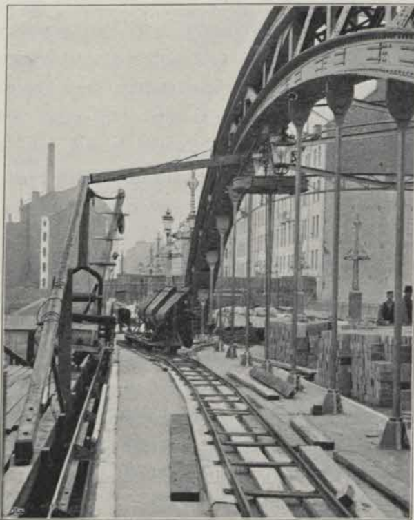
Fig. 36. Körbanans kubbläggning.
