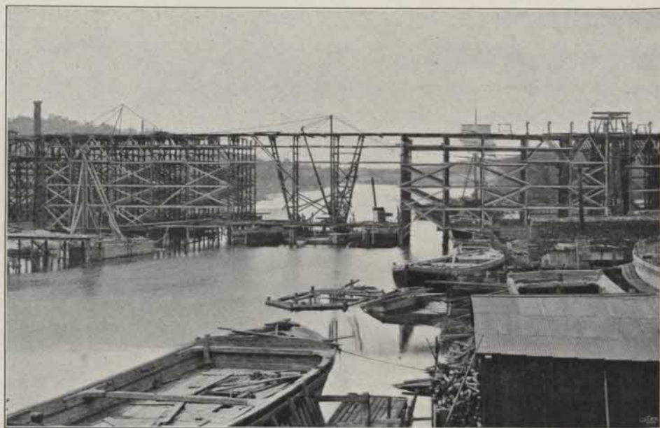
Fig. 29. Sidovy af byggnadsställningen med genomfarter för sjötrafiken.
