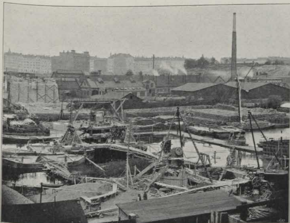
Fig 13. Vy af arbetsplatsen under pågående grundläggningsarbete.
