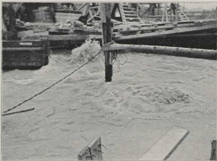
Fig. 5. Tryckluften kastar upp lervatten omkring pelaren.
