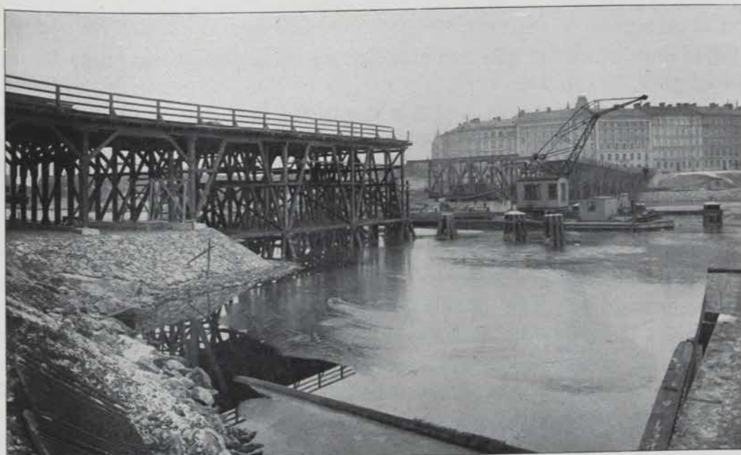
BROBYGGNADEN FRÅN STRANDEN VID LILJEHOLMENS STATION MED SVÄNGBRON UNDER UPPSÄTTNING. 23 NOV. 1914.
