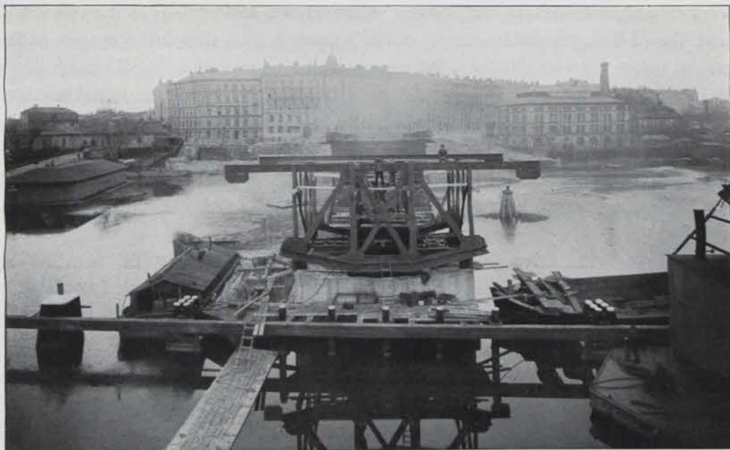
SVÄNGPELAREN M. SVÄNGBRON UNDER UPPSÄTTNING, SEDD FR. SÖDRA DELEN AV TRÄBRON. 23 NOV. 1914.
