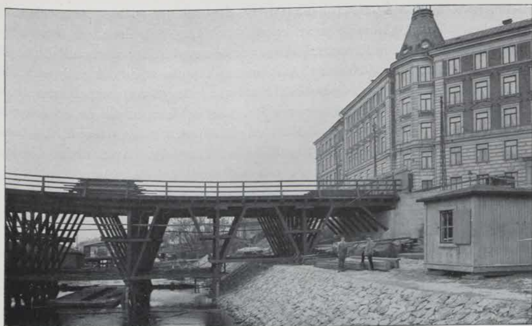
NORRA LANDFÄSTET MED TRÄÖVERBYGGNADEN NÄRMÅST DETSAMMA FULLBORDAD. 23 NOV. 1914.
