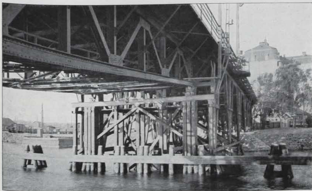
UPPLAG Å TRÄBRON FÖR SVÄNGSPANNET VID DESS SÖDRA ÄNDA. JUNI 1915.
