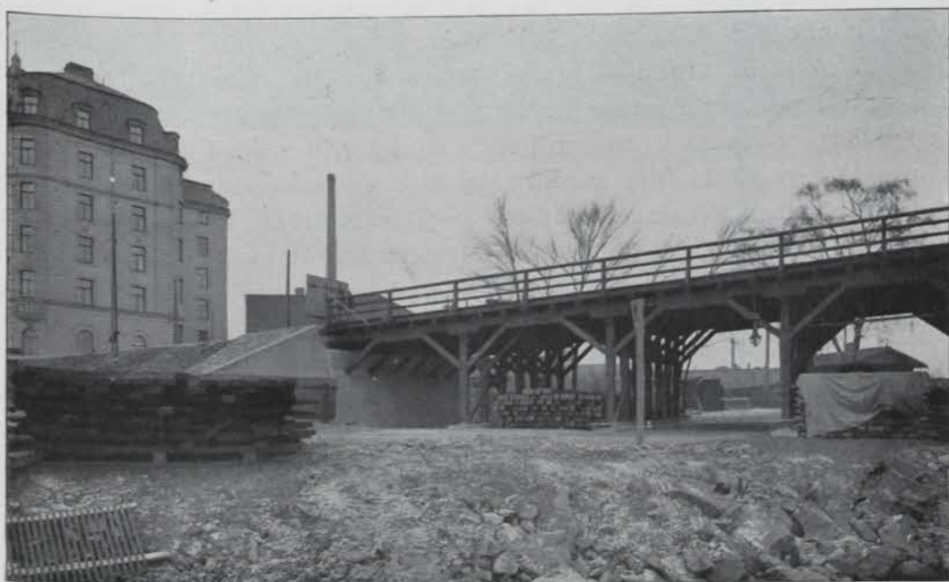
VIADUKTEN ÖVER LILJEHOLMENS STATIONSONRÅDE MED FULLBORDAD TRÄÖVERBYGGNAD. 23 NOV. 1914.
