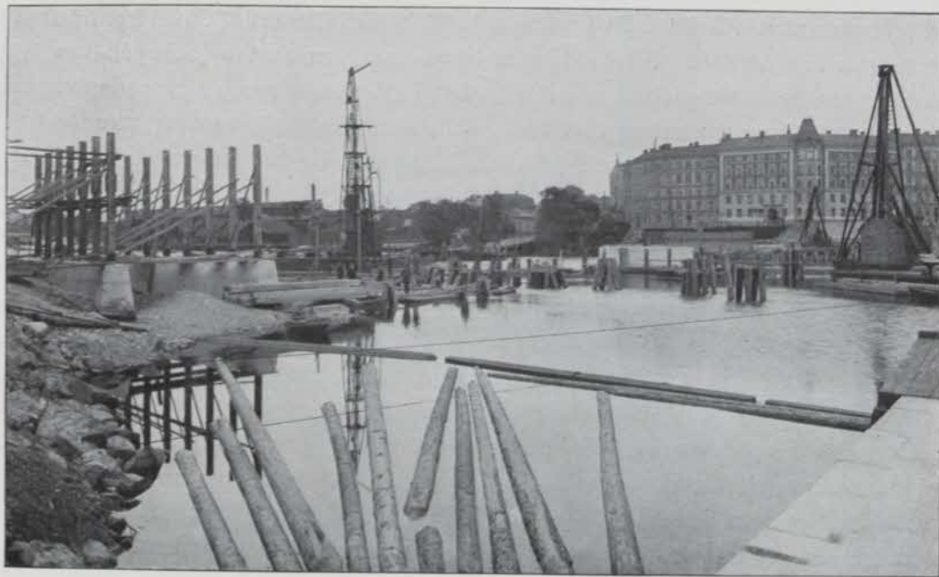
SÖDRA DELEN AV BROBYGGNADEN UNDER PÅGÅENDE PÅLNING OCH UPPSÄTTNING. MAJ 1914.
