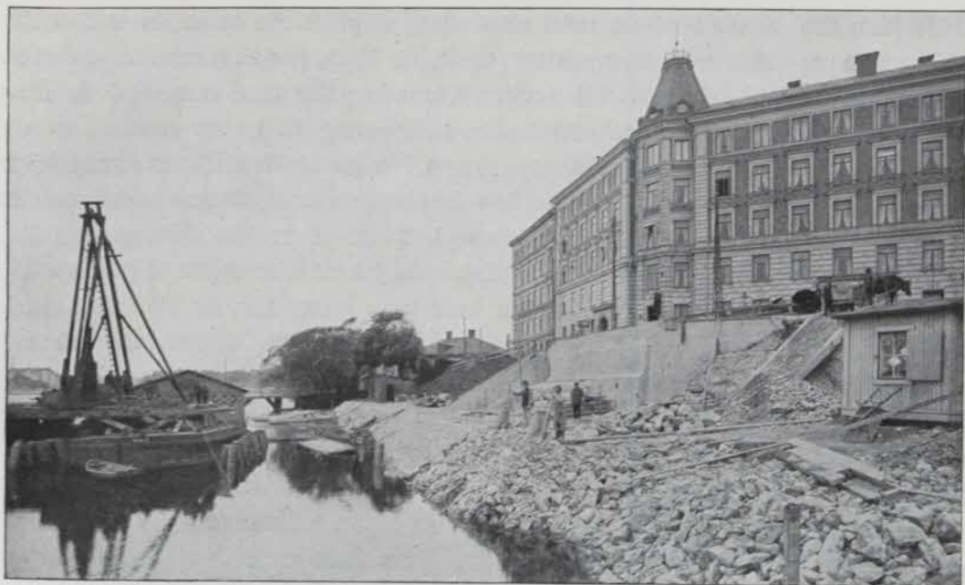
NORRA LANDFÄSTET SAMT PÄLNING FÖR NORDLIGASTE BOCKSTÖDEN. MAJ 1914.
