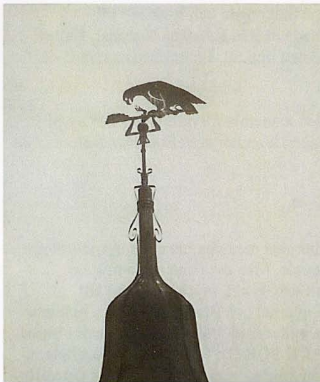
Bild 17. Fotografi från 1937 av den dåvarande vindflöjeln
