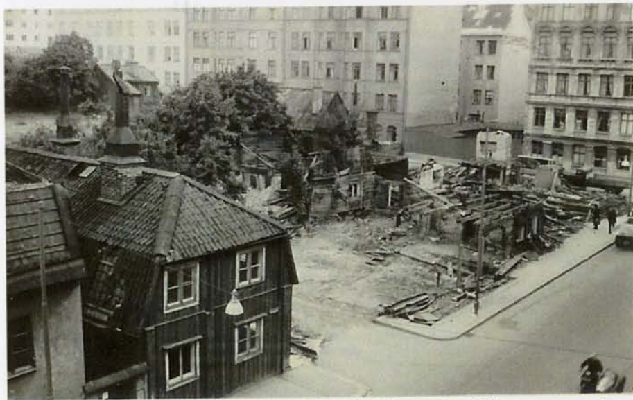
Bild 8. Rivning för byggandet av hörnhuset Högbergsgatan/Timmermansgatan 1937.
