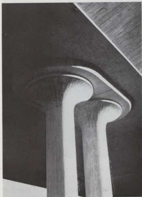
Fig. 58. Viadukten över Rålambstorg. Dubbelpelare.
