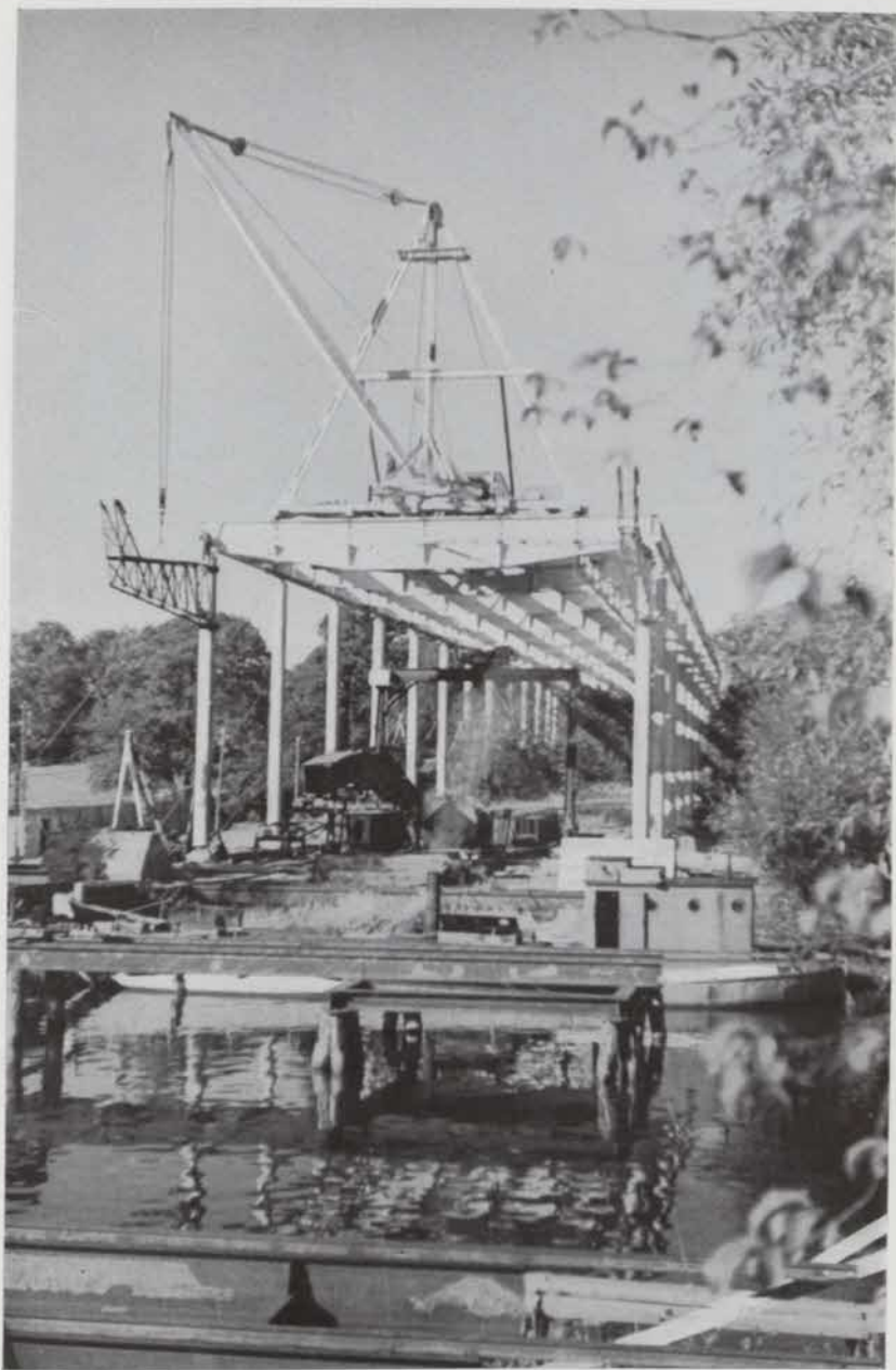
Fig. 43. Pälundsbrons viadukt på Långholmen under montering.
