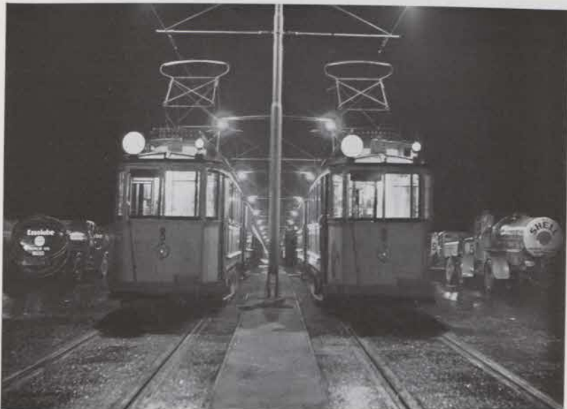
Fig. 37. Provbekastning av bron.
