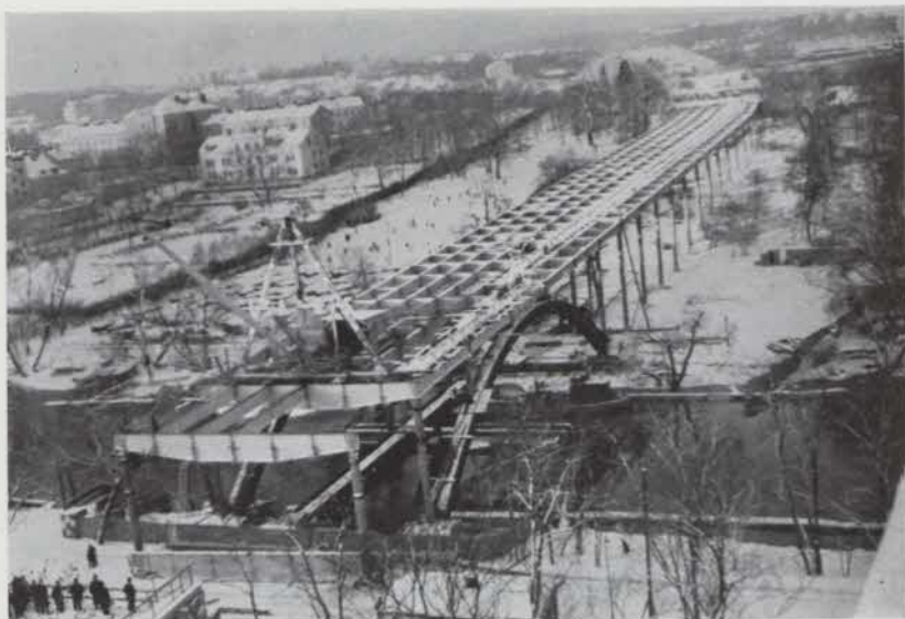
Fig. 44. Pålundsbron under montering.
