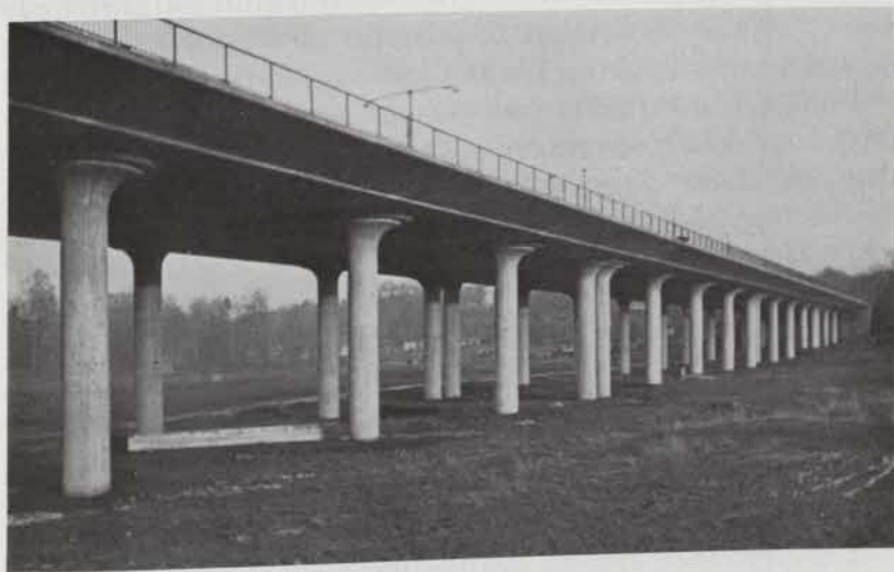
Fig. 57. Viadukten över Rålambstorg.
