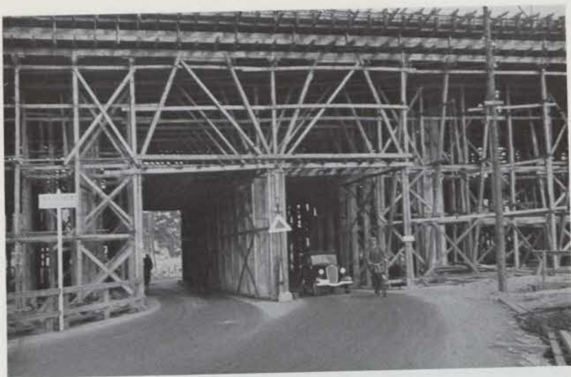
Fig. 55. Viadukten över Rålambstorg. Formställning.
