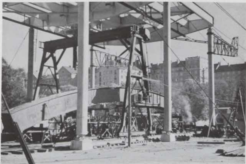
Fig. 41. Pälsundsbrons bågar under tillverkning.
