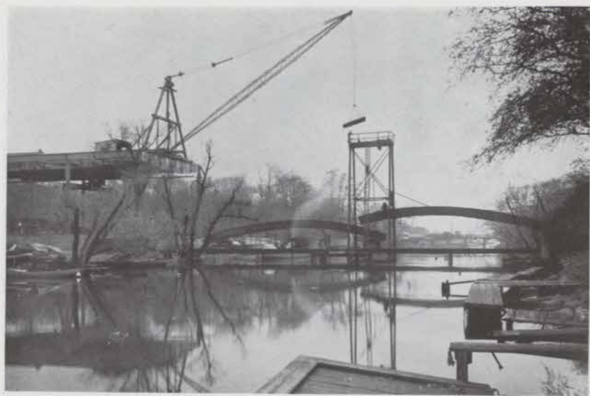
Fig. 42. Pålundsbrons båge under montering.
