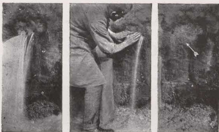
Dubbelt vattengenombrott, tätat på ett par minuter med Tricosal S III.
