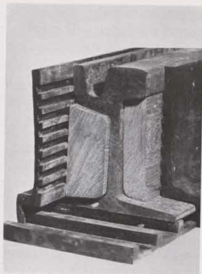
Fig. 24. Gummisolering kring spårvägsräls.
