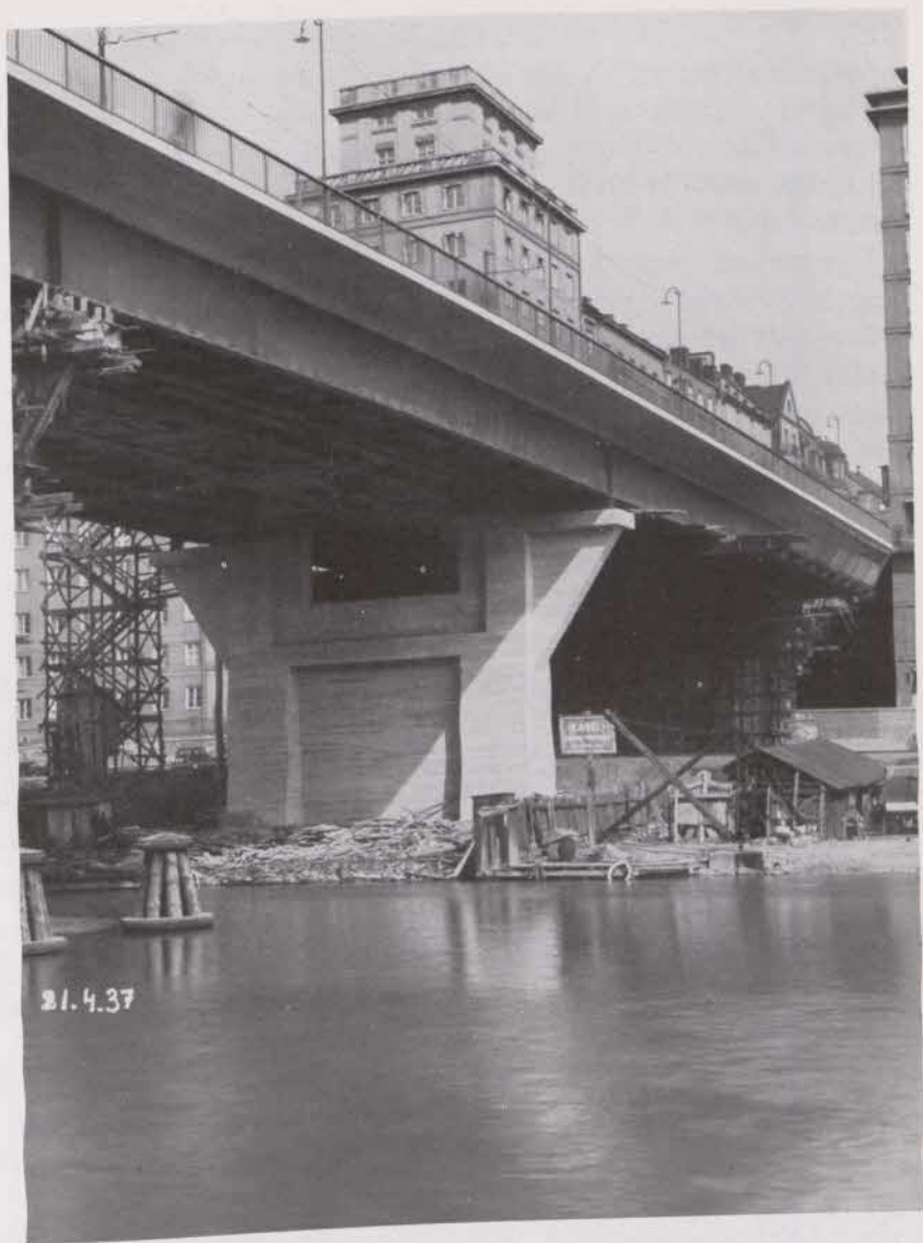
Fig. 27. Överbyggnad och en mellanpelare sedda från Kungsholmsstrand.
