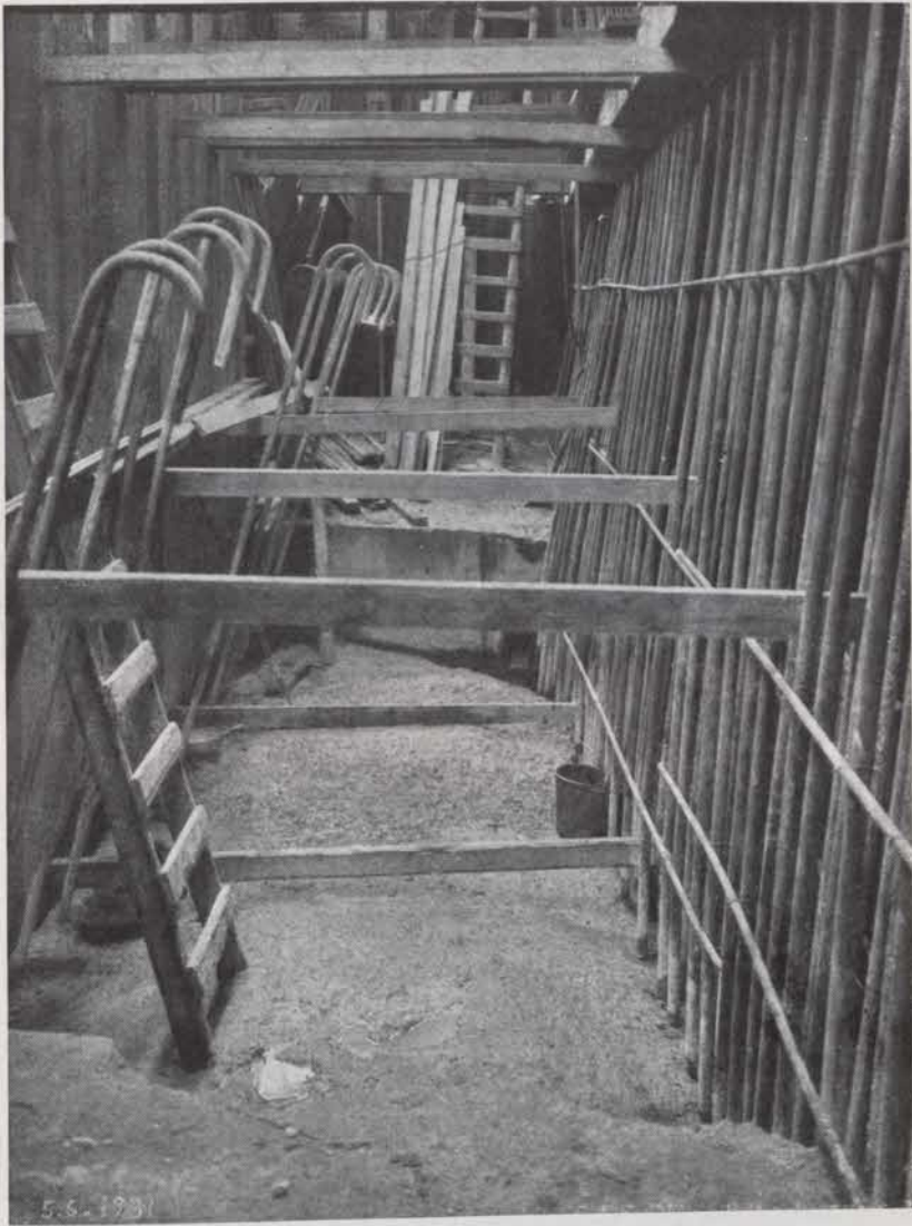
Landfäste under byggnad. Bottenplattan gjuten.
