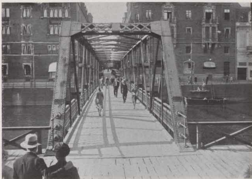
Gångbron från Helgeandsholmen.
