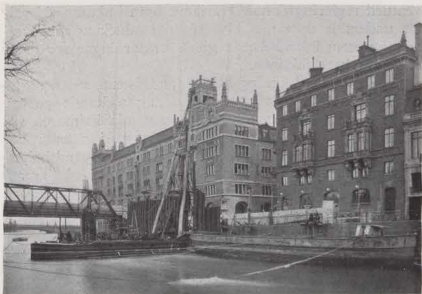
Nedslagning av järnspons för nya brons norra landfäste.
