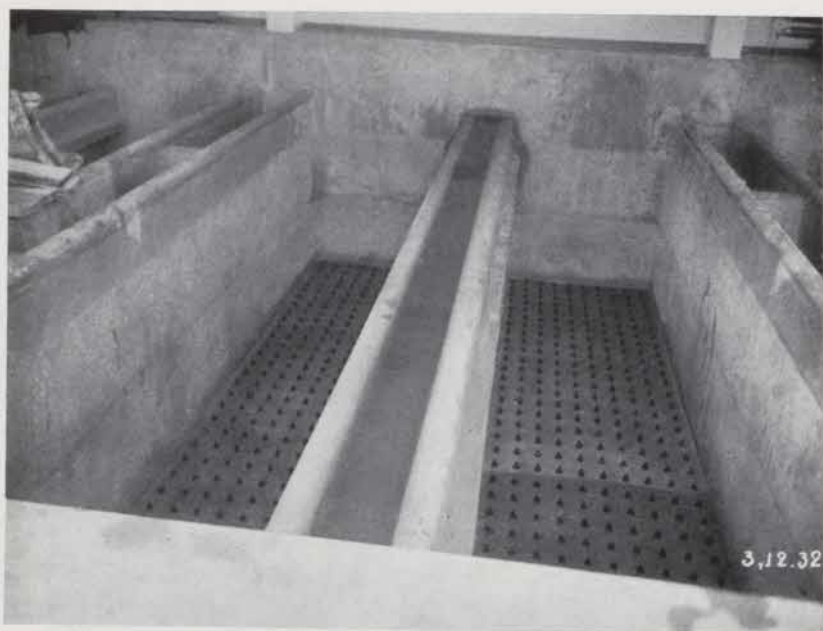
Filterbotten med munstycken.
