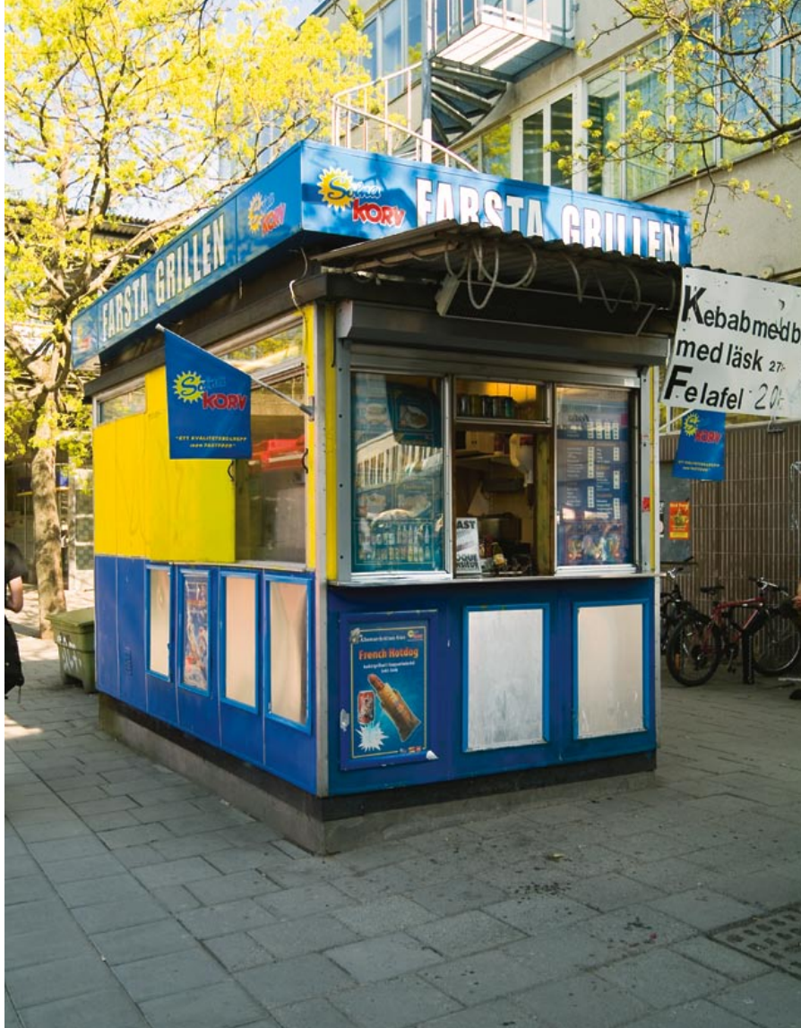
Karosseri AB Allvin & Östlund tog fram en typkiosk som kallades Stockholmskiosken. Den tillverkades i regelkonstruktion och bekläddes utvändigt med glasfiberarmerad plast. Kiosken var typgodkänd av Stockholms stads gatukontor och Hälsovårdsnämnden i Stockholm. Kiosken på bilden finns i Farsta centrum. Foto: Mauro Rongione, SSM.
