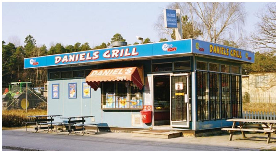
Daniels Grill vid Gamla Södertäljevägen i Fruängen är en typkiosk från Karosseri AB Allvin & Östlund. Den är en av få kiosker från början av 1970-talet som står oförändrad sedan byggnadstiden med ursprungliga blå pentagon-fasadplattor. En ny detaljplan är antagen för området som innebär att kiosken ska flyttas och ge plats för ett nytt bostadsområde. Foto: Josefine Bolander, SSM.
