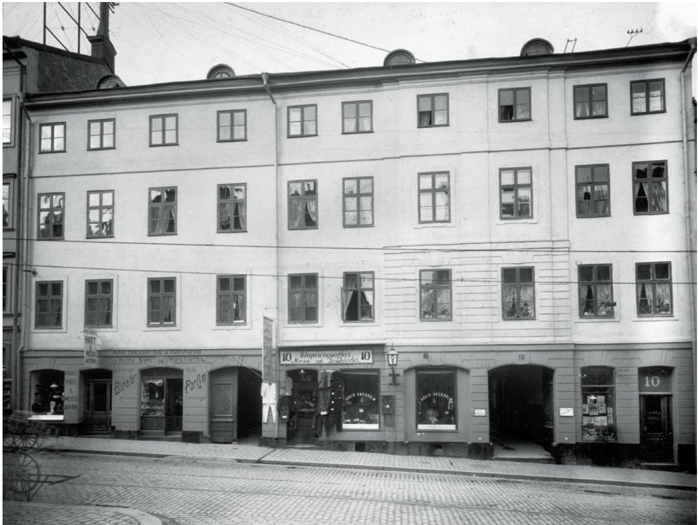
Fasaden till Moriens hus vid Hornsgatan 10 innan rivningen. Stockholms stadsmuseums samlingar.
