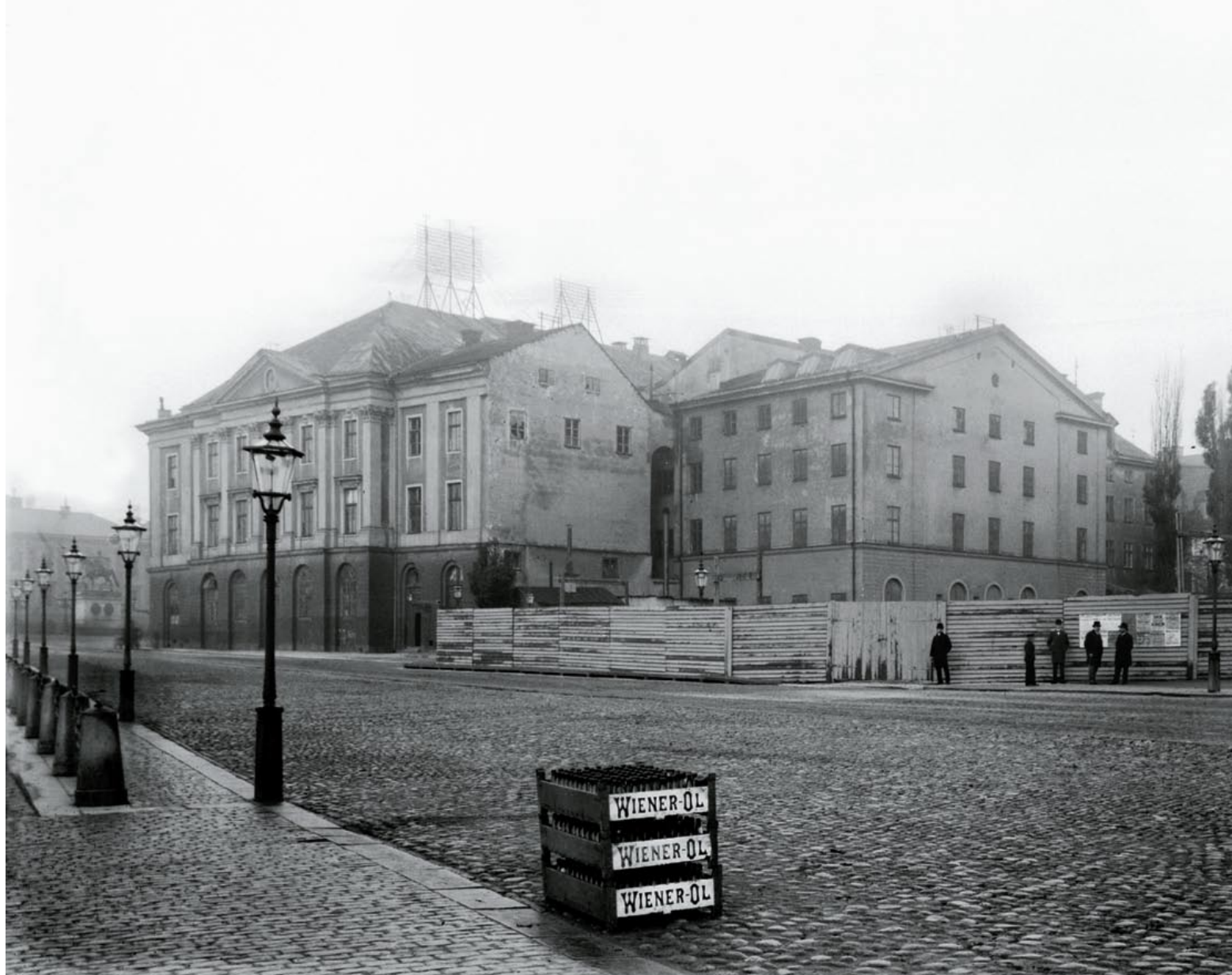
Kungliga teaterns baksida sedd från öster. Den utskjutande mittrisaliten mot Strömmen utgjorde scenens baksida och yttervägg. Genom de höga portarna nederst kunde större föremål, t.ex. dekorationer och hästar, föras in och ut från scenen. Den östra delen av byggnaden med den brandväggslänkande fasaden dölde loger och verkstäder. Foto: 1890-tal, Stockholms stadsmuseums samlingar.
