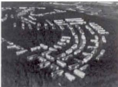
När byggandet kom igång förvandlades skogsområdet snabbt till ett av Stockholms första smalhusområden. Det blev samtidigt den första sovstaden, utan några egna större arbetsplatser. Flygbild över norra Hammarbyhöjden. Foto: Oscar Bladh, Stockholms stadsmuseum.
