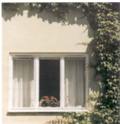
Fönstren placerade i fasadliv är stora och utan spröjs. I Stockholmsbostads hus i norra Hammarbyhöjden är alla innerrutor numera av sk energiglas.
