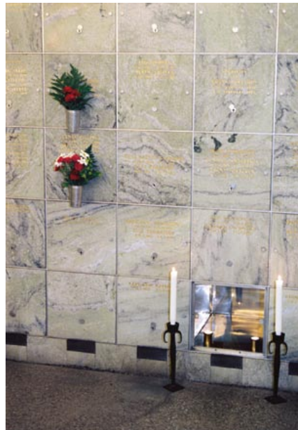
Engelbrekts kolumbarium. Urnfacken är konstruerade av metall med en så tunn fog mellan täckplattorna att det ger intryck av en hel mur av marmor. Här är det förberett för gravsättning. Foto: Göran Fredriksson, SSM.
