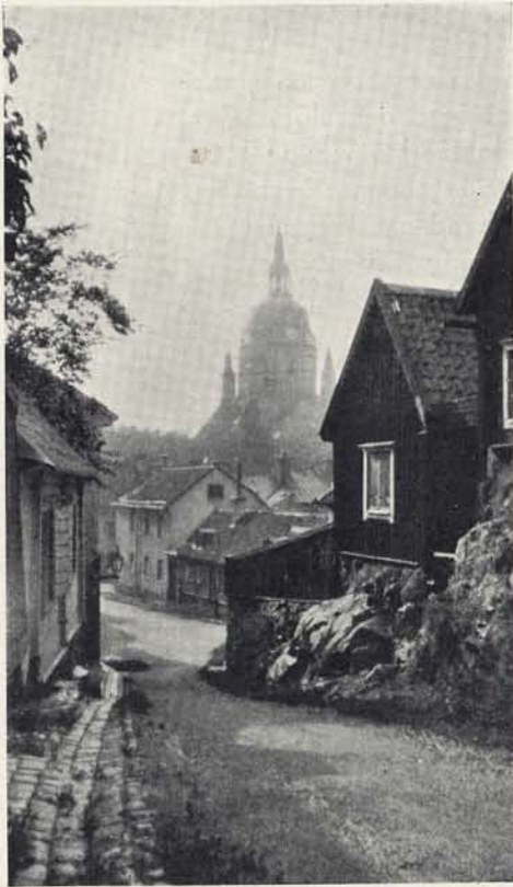
98. Från Stigbergsgatan väster om uppfartsvägen
