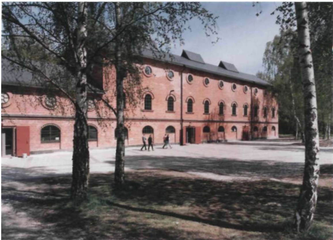
Nobels svavelsyrafabrik från 1891 har rustats upp och rymmer numera Skulpturens Hus. Byggnaden, som är K-märkt, rymmer även ett museum över Alfred Nobel och industriverksamheten på platsen. Arkitekter för ombyggnaden var Stefan Hagdahl och Ola Tafvelin.
