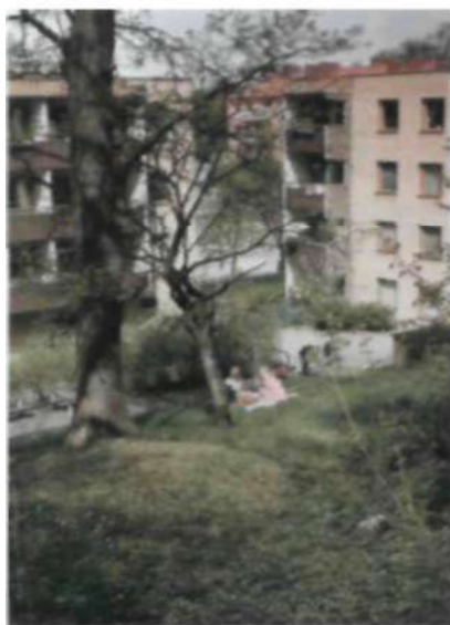
De platta taken och de släta fasaderna i ljus tegel med utskjutande balkonger är neutralt modernistiska i sitt uttryck.
