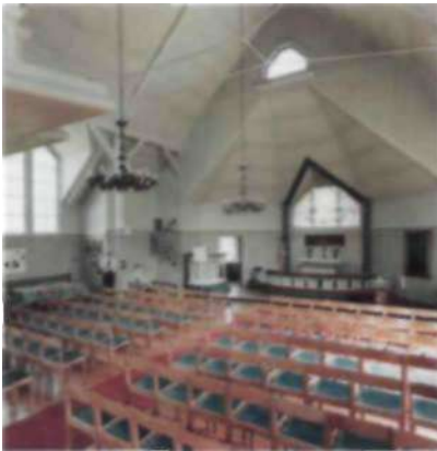
Kyrkans interiör är ljus och luftig, och takkonstruktionen sammanbinds av järnkare.
