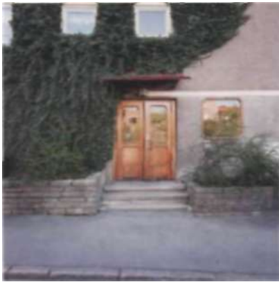
Planteringar vid husväggarna avgränsas av stödmurar i natursten. Sockelvåningen markeras med en vit list och har fått en annan färgton än huset i övrigt.
