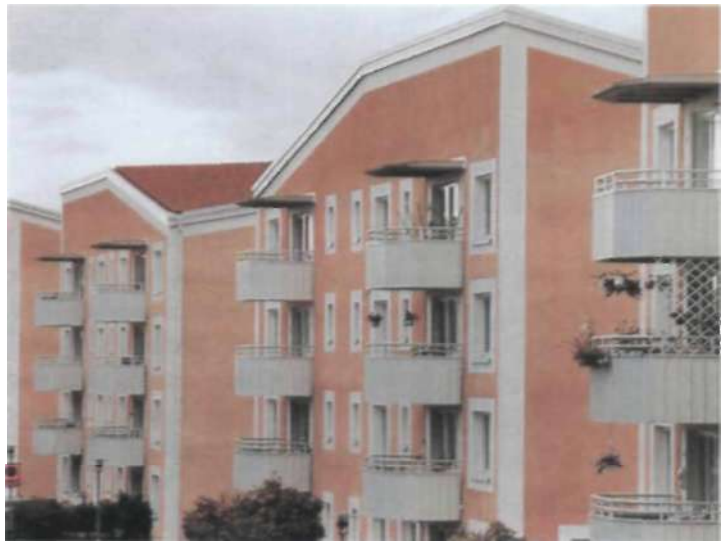
Stockholmshems område i Västra Smedshagen, Hässelby. De spritputsade fasaderna med breda fönsteromfattningar är en tydlig koppling till 1950-talsarkitekturen.
