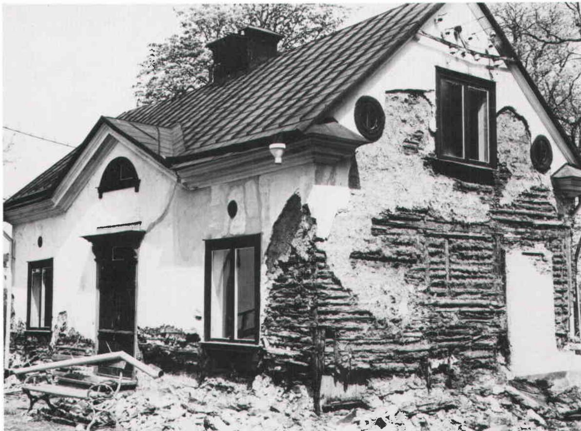
Östra flygeln på Karlshälls gård under renovering 1951. Där puts och lerklining fallit av ser man horisontala slantar som antyder en märklig konstruktion. Foto Folke Larcke, SSM.
