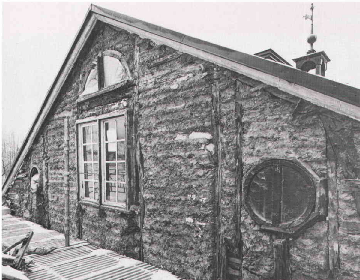
Karlshäll, östra gaveln under ombyggnad 1986 med stommen blottlagd. De små runda gavelfönstren har ingjutna åttkantiga fönsterkistor. Foto G Fredriksson, 1986.
