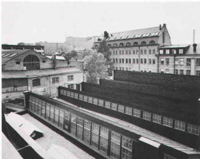
Den ursprungliga verkstadsbyggnadens sågtak. Där bakom plåtslagareverkstaden och kontorshusen. Foto 1982.
