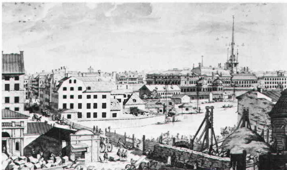
Utsikt från Gustav Adolfs torg (dåvarande Normalmstorg). Till vänster syns Braheska huset och i bakgrunden till höger Riddarhuset och Riddarholmskyrkan. I förgrunden pågår rivningen av Torstenssonska palatset. Byggnaden med portalen är Corps de Garde. Lavering av E Palmstedt 1780-talet.
