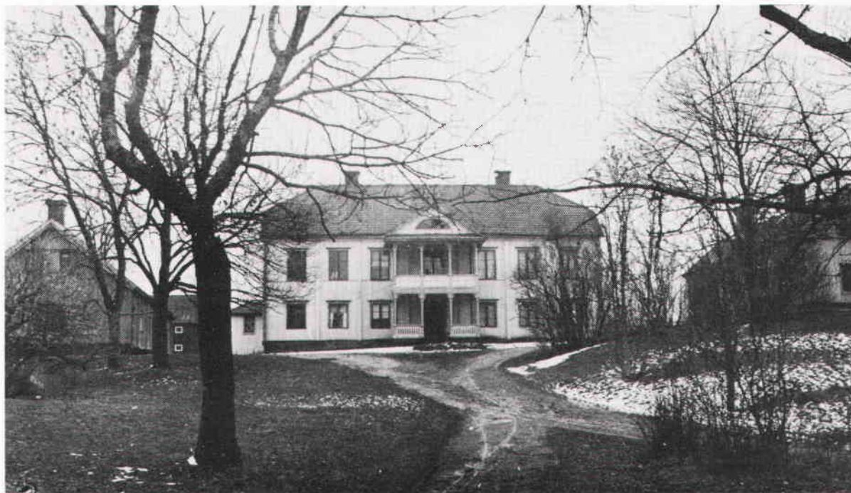
Hägerstalunds gård år 1918. Till höger den nu nedbrunna flygeln som förhoppningsvis kommer att återuppföras. Huvudbyggnadens mittparti har idag en något annorlunda utformning.
