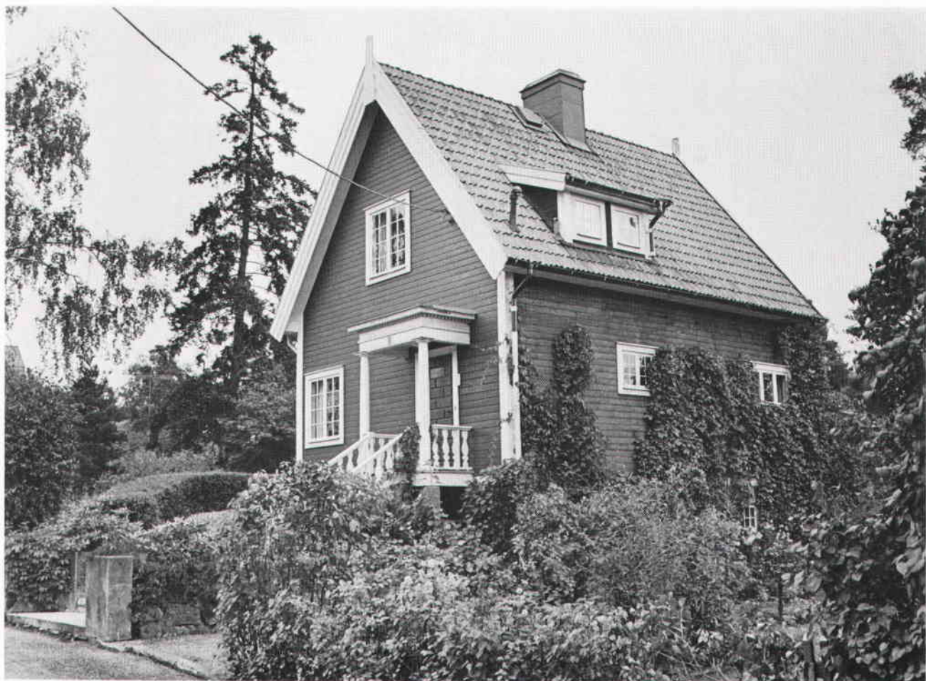
Villa på Bågspännarvägen, kv Svärskiftet 18, i Älvsjö. En av de få villor som så gott som helt behållit sin ursprungliga karaktär sedan byggnadstiden på 1910-talet.
