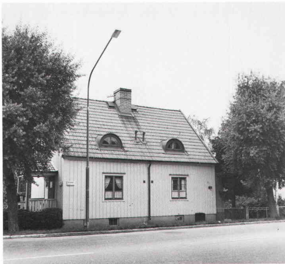
Parvilla i kv Kavelbron, uppförd 1926. En av de fastigheter längs Älvsjövägen som enligt den aktuella planutredningen för Älvsjöområdet skall rivas.
