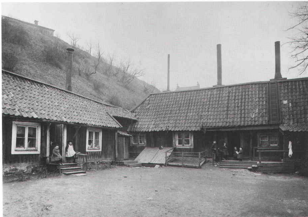
Längorna efter 1870-talets renovering. Till höger fönstret till östra lägenhetens kök, i byggnadens äldsta del, och lägenhetens utbyggda förstuga. Foto Ateljé Larsson, 1902, i SSM.
