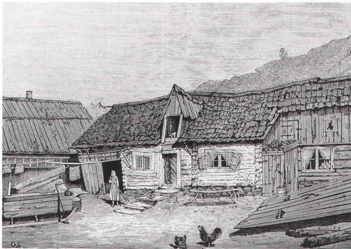
Västra längan före 1870-talets renovering. Dörren under takkupan leder in till längans äldsta del, det så kallade brygghuset. Till höger luckorna till källartrappan. Teckning ur Ny Illustrerad Tidning 1875.
