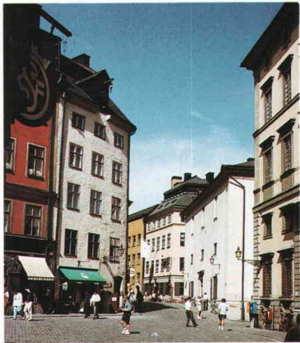
Stockholmshusen är av tradition uppförda med tegelmurar och kalkputsade fasader. Exemplet här Järntorget. Foto Margareta Cramér 1992.
