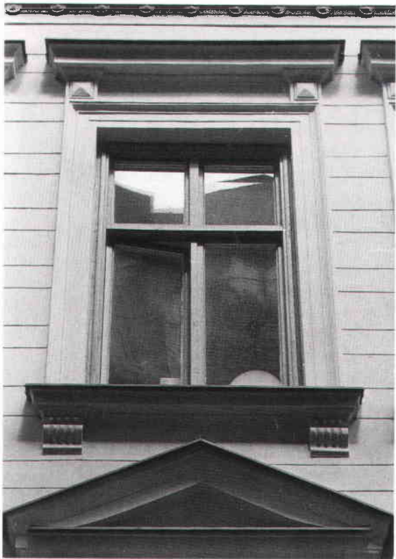
Samma fasad som på sid. 51 efter blästring, med nya gipsornament, ny ytputs och avfärgning med Stråbrukens färdigblandade kalkfärg. Foto Göran Fredriksson 1992. SSM.
