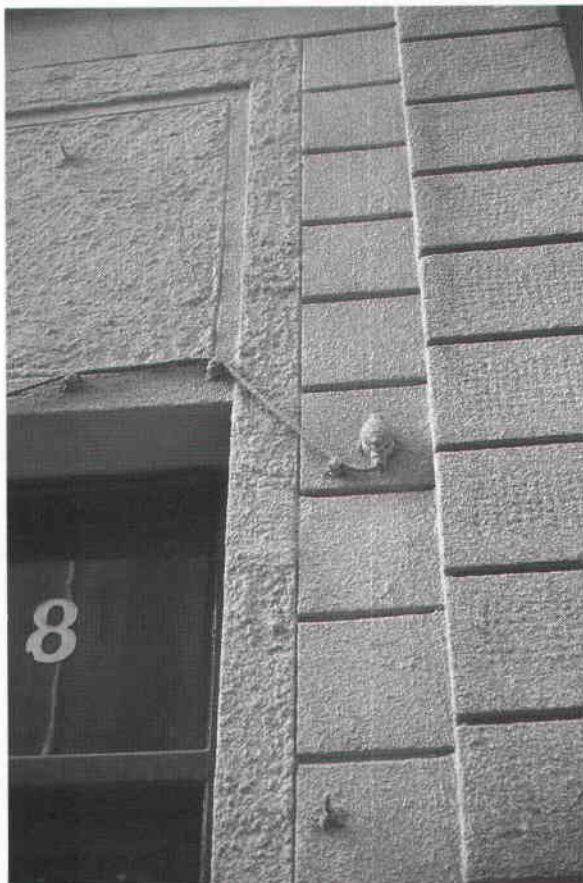
Sprutad KC-färg från 1960-talets slut över gammal puts, stenornament och ledningar, Tyska Brinken 28. Ballast i färgen har medfört en knottrighet som samlar smuts. Foto Margareta Cramér 1974. SSM.
