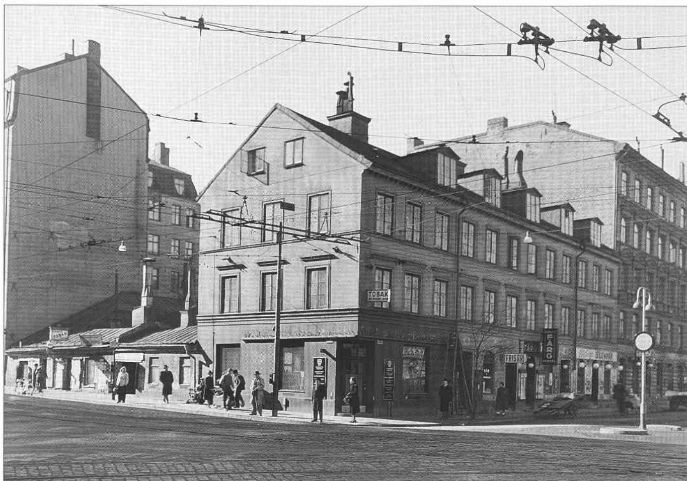
Nedan: Renstiernas Gata 18 och Folkungagatan 106–108. Foto: Du Puy 1946. Fastigheterna rivna strax efter fotograferingen.
