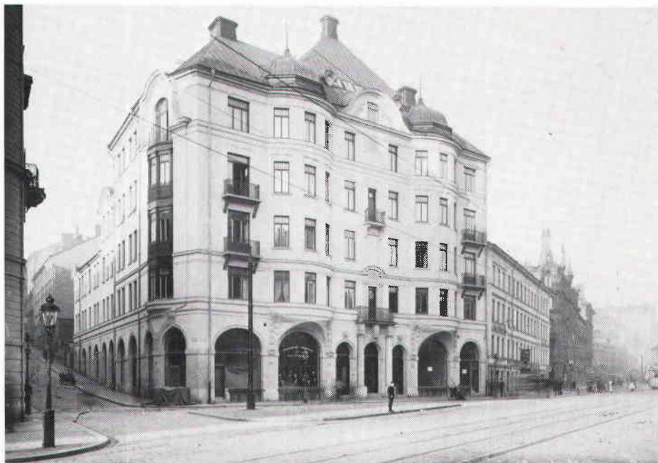
Jugendhus med bottenvåning av huggen sten och däröver fasadputs i närliggande kulör. Birger Jarlsgatan 25, byggt 1902-04 Foto A. Blomberg 1904.
