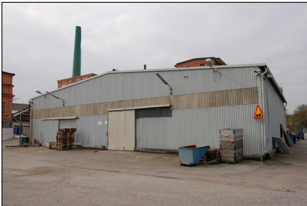
Byggnad nr. 39 från nordost. Prosaisk men fyller sin funktion som lager. Ett band med transparent glasfiber ger dagsljus. (Foto: Leif Bivegård)
