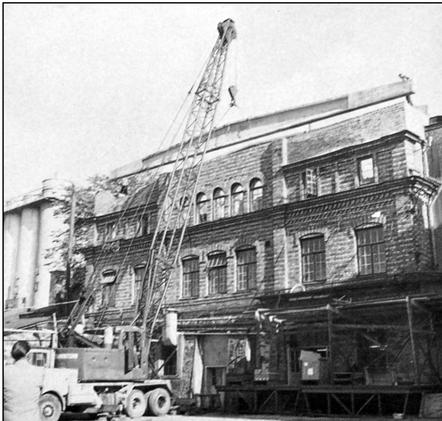
Fotografi taget under påbyggnaden 1958, då översta våningen höjdes 1,5 meter. Förändringen gjorde byggnaden oproportionerlig och klumpig. Den tidigare karakteristiska kreneleringen med sina tinnar, och namnskylten försvann av någon anledning mellan 1949 och 1951. (Ur Beckers arkiv)
