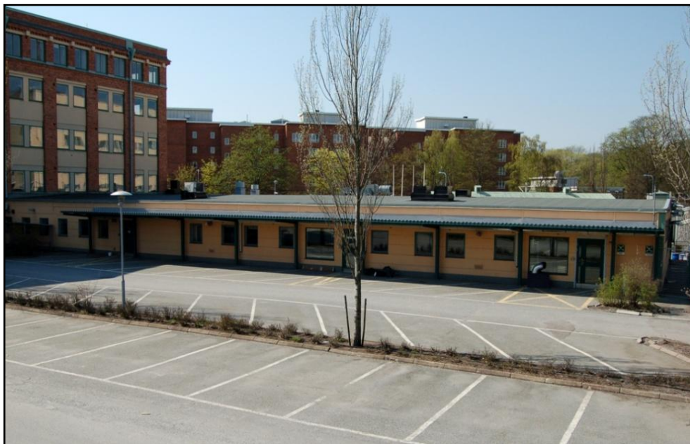
Samma byggnad från nordost. (Foto: Leif Bivegård)
