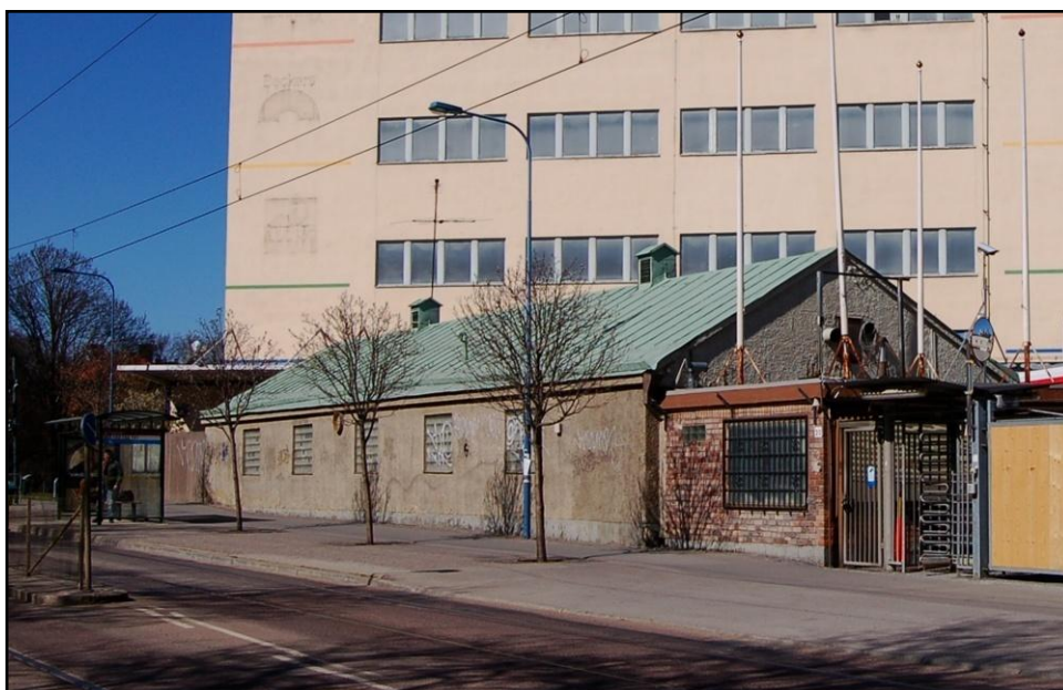
Byggnad nr.5 och 3, maj 2008. Husen skapar en spännande kontrastverkan vid Lövholmsvägen. Fönstren mot vägen är sedan 1960 av glasbetong. (Foto: Leif Bivegård)
