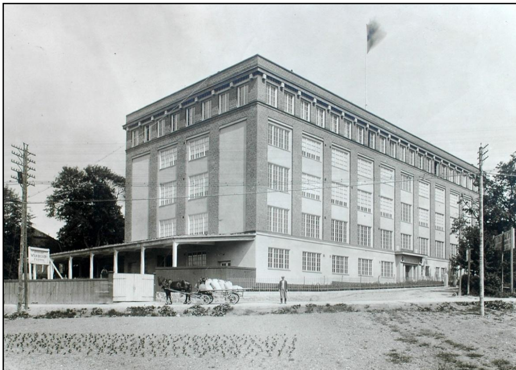
Kontorsbyggnaden 1917. Mäktig arkitektur reser sig på Liljeholmen. Klassiska former, komplett med kraftig sockel, lisener, arkitrav, fris och gesims! (Foto från Måleriyrkets museum)
