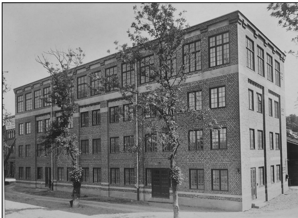
Förbandsfabriken 1916. Den strama arkitekturen har tydliga inslag av klassicism med indragna partier i fasaden som visualiserar pelarkonstruktionen, och takfotslisten som associerar till kapitäl. (Foto från Måleriyrkets museum)
