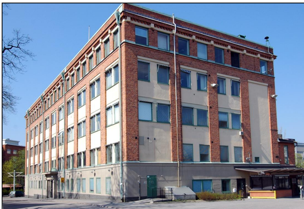
Kontorsbyggnaden från väster, maj 2008. Trots stora ingrepp, främst på fönster, har byggnaden kvar mycket av sitt forna uttryck. (Foto: Jonas Vikström)
