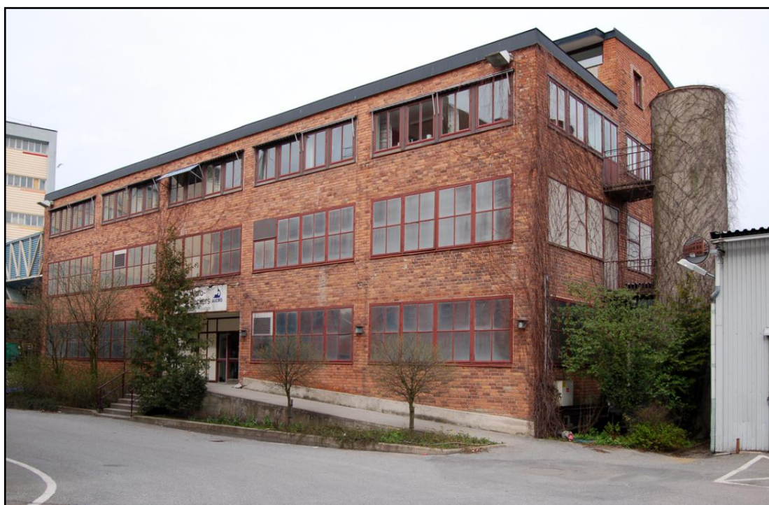
Nitrolackfabriken maj 2008. Den tidigare nedfarten är igenfylld, och fått en betongramp samt en plantering. (Foto: Leif Bivegård)
