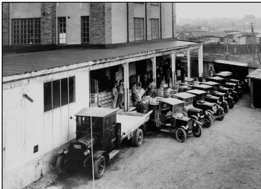
På 1920-talet byggdes kajen in i dess norra del. En utformning den i stort sett behöll till 1962. (Ur Beckers arkiv)
