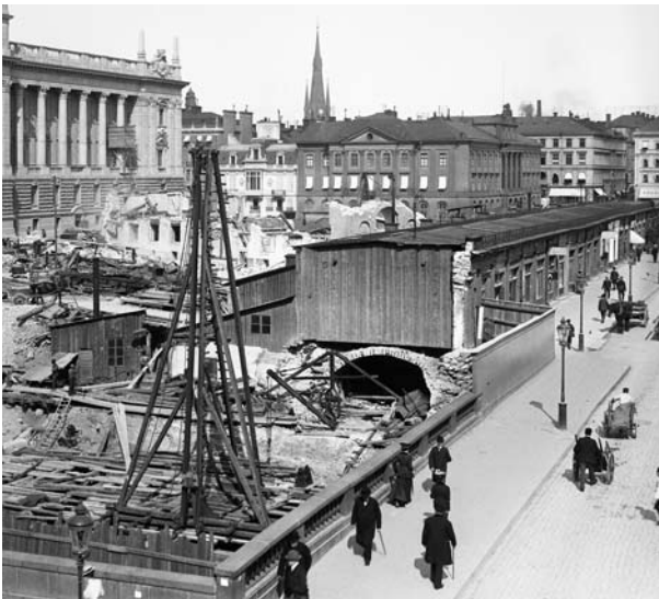
Basarbyggnaden under rivning 1903. Notera valvet under byggnaden och den murade fasaden med stuckdekor mot Norrbro. Bildens beskuren, fotograf okänd, SSM F 1412.
