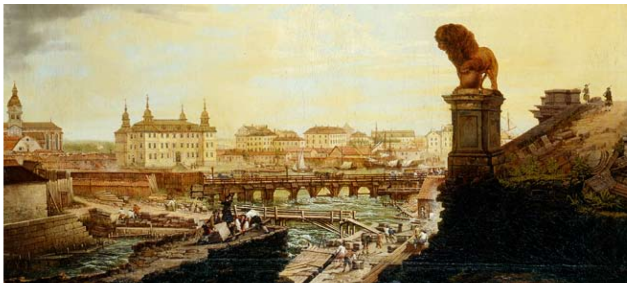
Byggnadsarbeten vid Norrströms södra strömgren (den blivande Stallkanalen) 1767.
