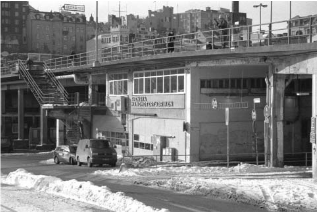
Lokal G från nordöst. Alla fönster på fasaden mot Saltsjön är sekundära. GF S2005-0014-06.
