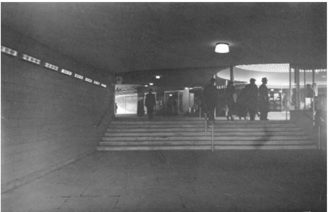
Bärande, smäckra stålpelare och en på dessa vilande ringbalk möjliggjorde ett cirkulärt, öppet rum under kupoltaket. Foto från 1930-talet. SSMA Fa 50851.
