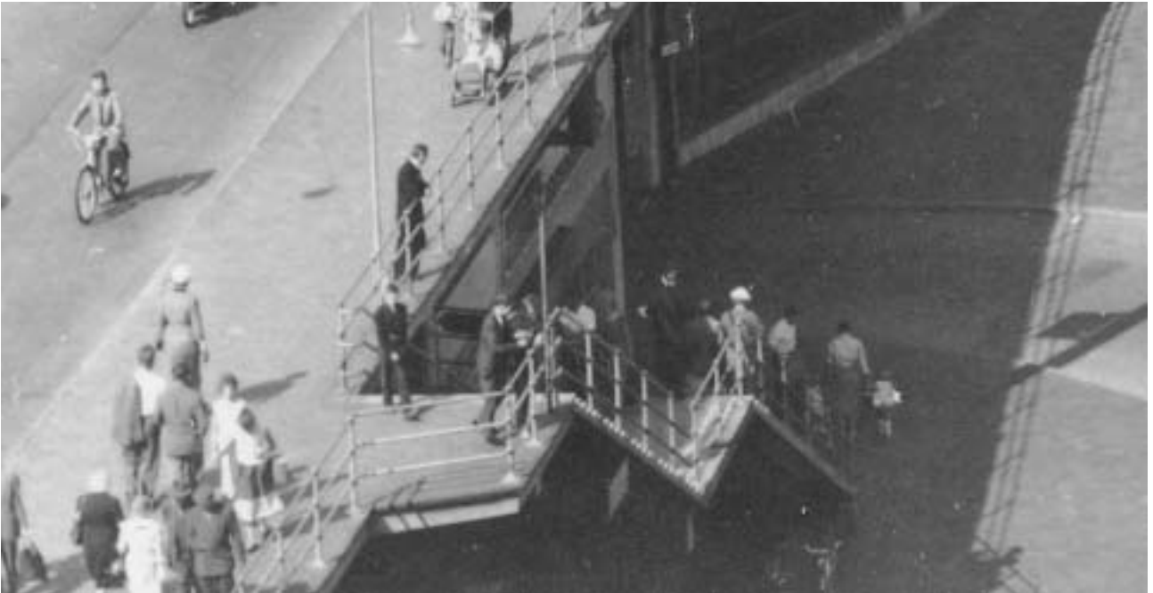
Trappa mellan Östra Slussgatan och trottoaren vid Saltsjörampen, som den såg ut innan det nedre loppet revs på 1980-talet. Utsnitt av fotografi från 1950-tal. SSMA Fa 50761.
