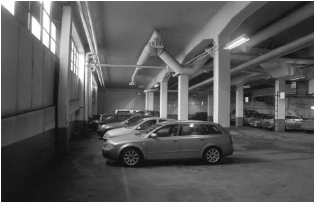
Garageutrymmena i Lokal C har denna karaktär: stora hallar med bärande betongpelare och stora stålfönsterpartier. Nytaget foto från den f.d. bilservicelokalen (Garage under Skeppsbron och Östra Slussgatan). GF S2005-0035-02A.
