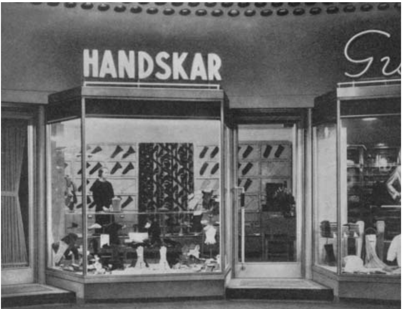
Foto från 1930-talet på fönster och dörrpartier i anodiserad aluminium i Blå Bodarna, här under kupoltaket med betongglas. Foto från Byggmästaren 1935 nr 38. Arkitektupplagan 13. Original i Arkitekturmuseets arkiv.
