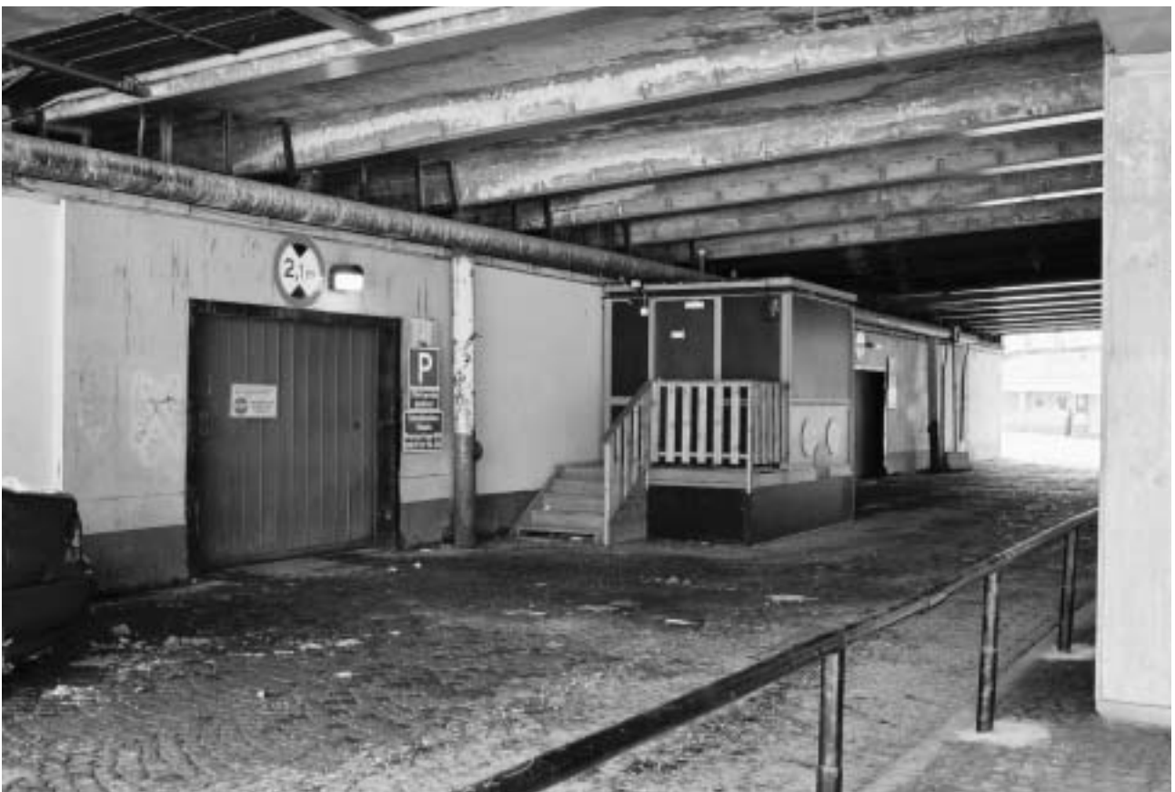
Nytaget foto över fasaden mot söder och Karl Johanslussen, mot väster. De ursprungliga skjutportarna finns kvar, men har fått nya infällda garageportar. GF SF05-0008-18A.
