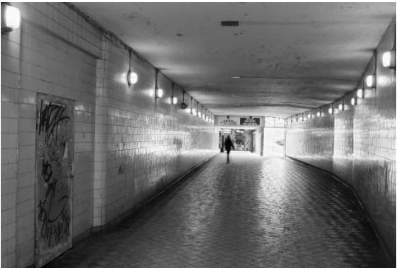
Nytaget fotografi över Gula Gångens mittparti, mot norr. Till vänster i bild ser man en av de idag igensatta öppningarna till Saltsjöbanan och Södermalmstorg. Dörren leder idag in till ett av de små förrådsutrymmena. GF SF05-0007-34A.
