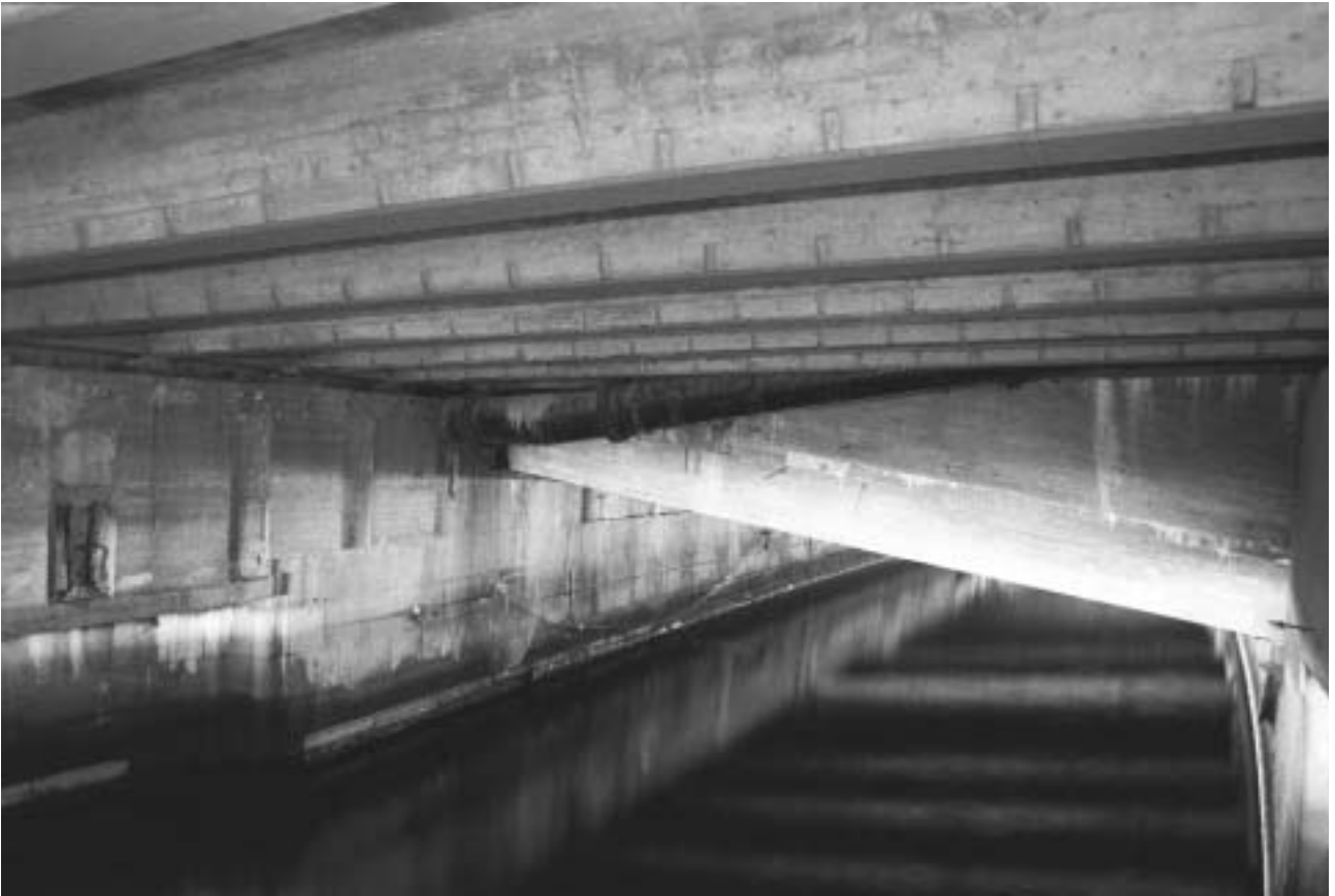
Nytaget foto från avtappningskanalen, gamla Nils Ericsonsslussen. De gamla kanalsidorna i granit är bevarade, under 1930-talets överdäckning i betong. GFS2005-0034-08A.
