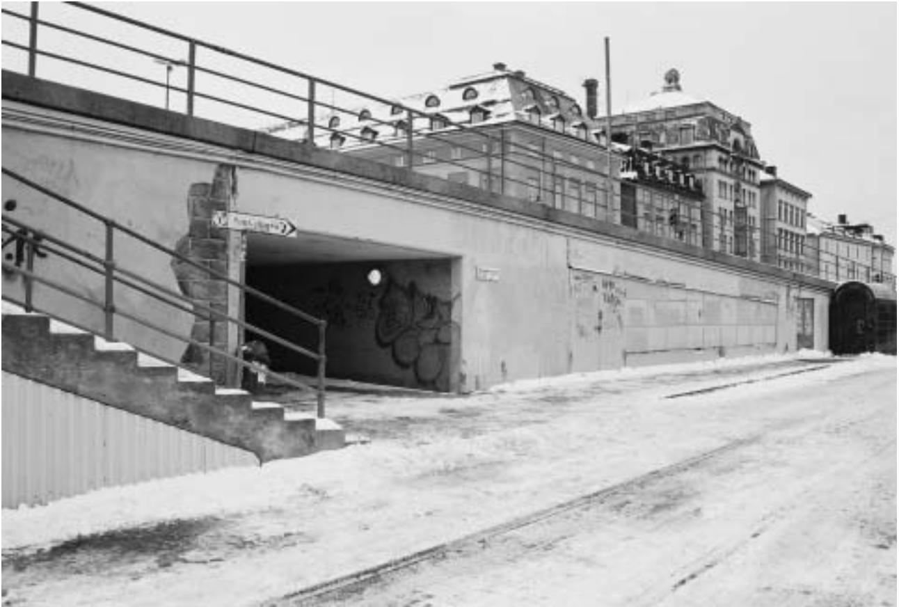
Lokal B, fasad mot öster. Lättbetongfasaden vid trappan är sekundär, här fanns ursprungligen stålfönster. Till höger i bild det förtäckta fönsterpartiet in till förrådet vid avtappningskanalen. Nytaget fotografi. GF SF05 0008-36A.
