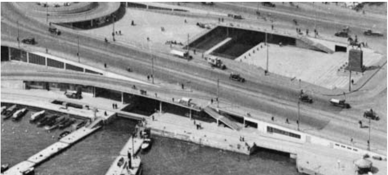
Omfattande fönsterpartier uppfördes i fasaderna mot Saltsjön, Karl Johans torg och Mälaren. Dessa lät man följa vägbanornas sträckning och inpassas mellan bärande pelare för att gestalta den konstruktiva formen i anläggningen. Utsnitt ur foto från 1939 av fotograf Oscar Bladh. SSMA Fa 50837.
