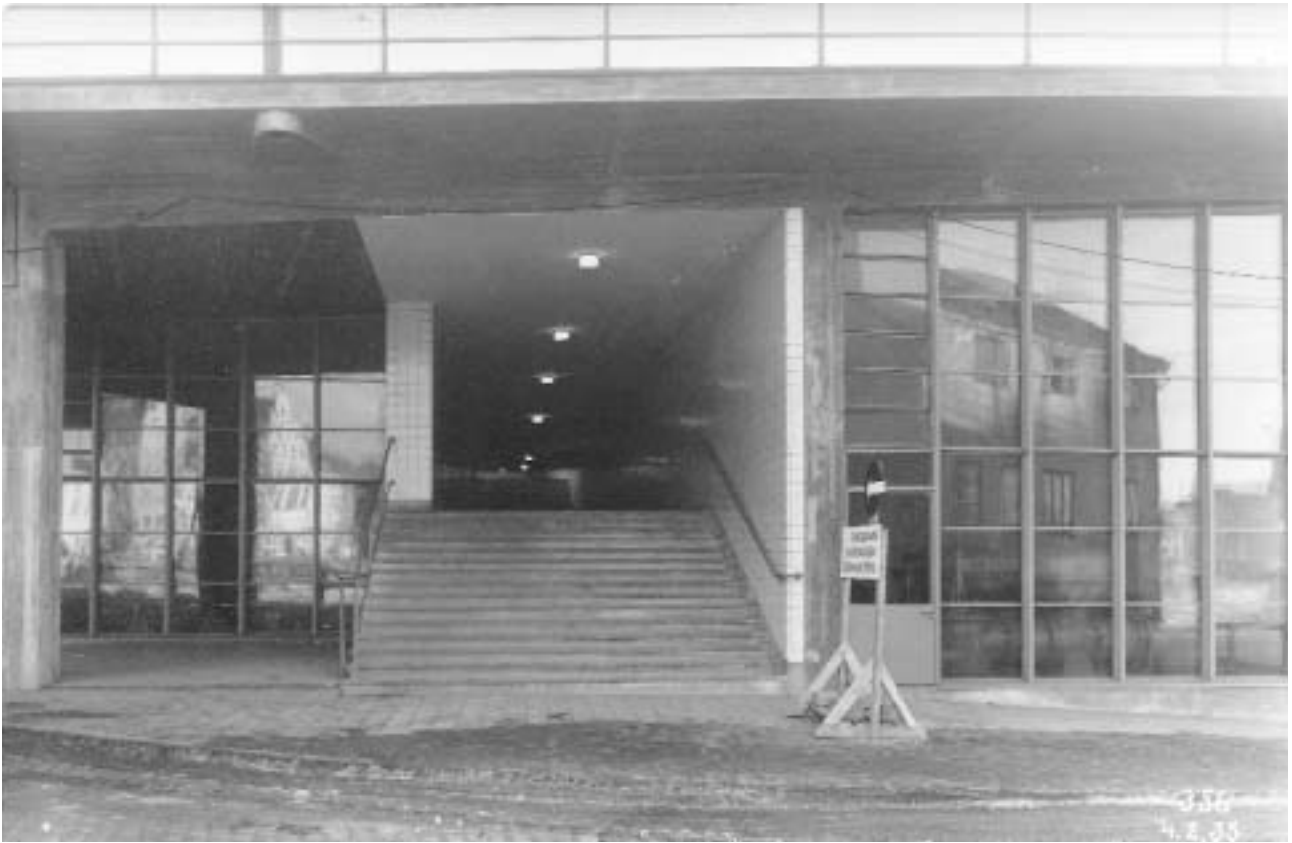
De ursprungliga fönsterpartierna vid Gula Gångens norra entré. Dessa höga och breda partier hade kraftiga stående "pelare" och något tunnare liggande profiler, sannolikt av stål. I det högra fönsterpartiet en ståldörr med glasning i överdelen. Fotografi från 1935. SSMA Fa 50854.
