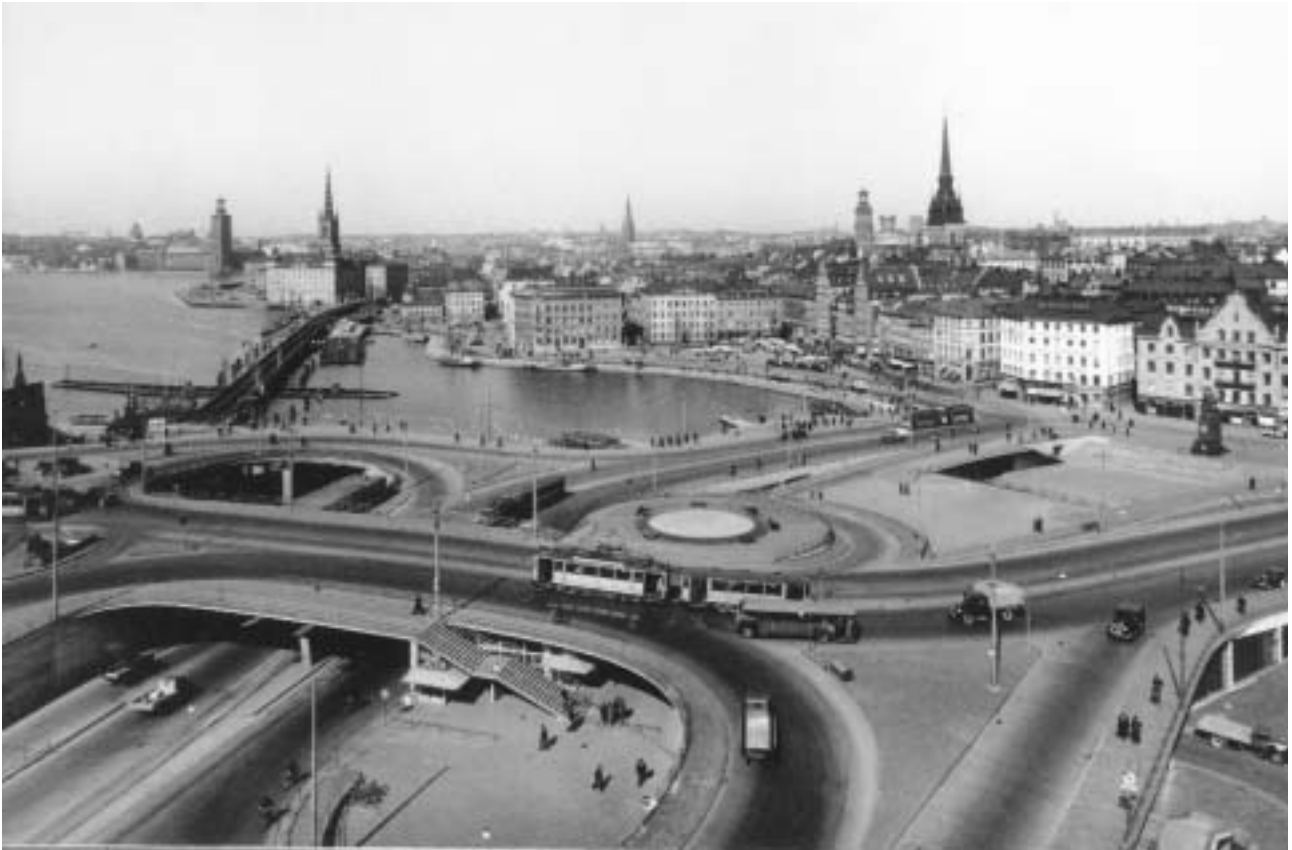
Vy från 1930-talet över anläggningens centrala viadukt korsning och klöverbladen. Bilden visar tydligt den ursprungliga markbeläggningen i rödbrun klinker. SSMA Fa 34115.
