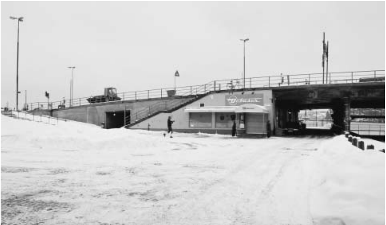
Fasad mot väster, Karl Johans torg. Nytaget foto. GFSF05-0008-24A.
