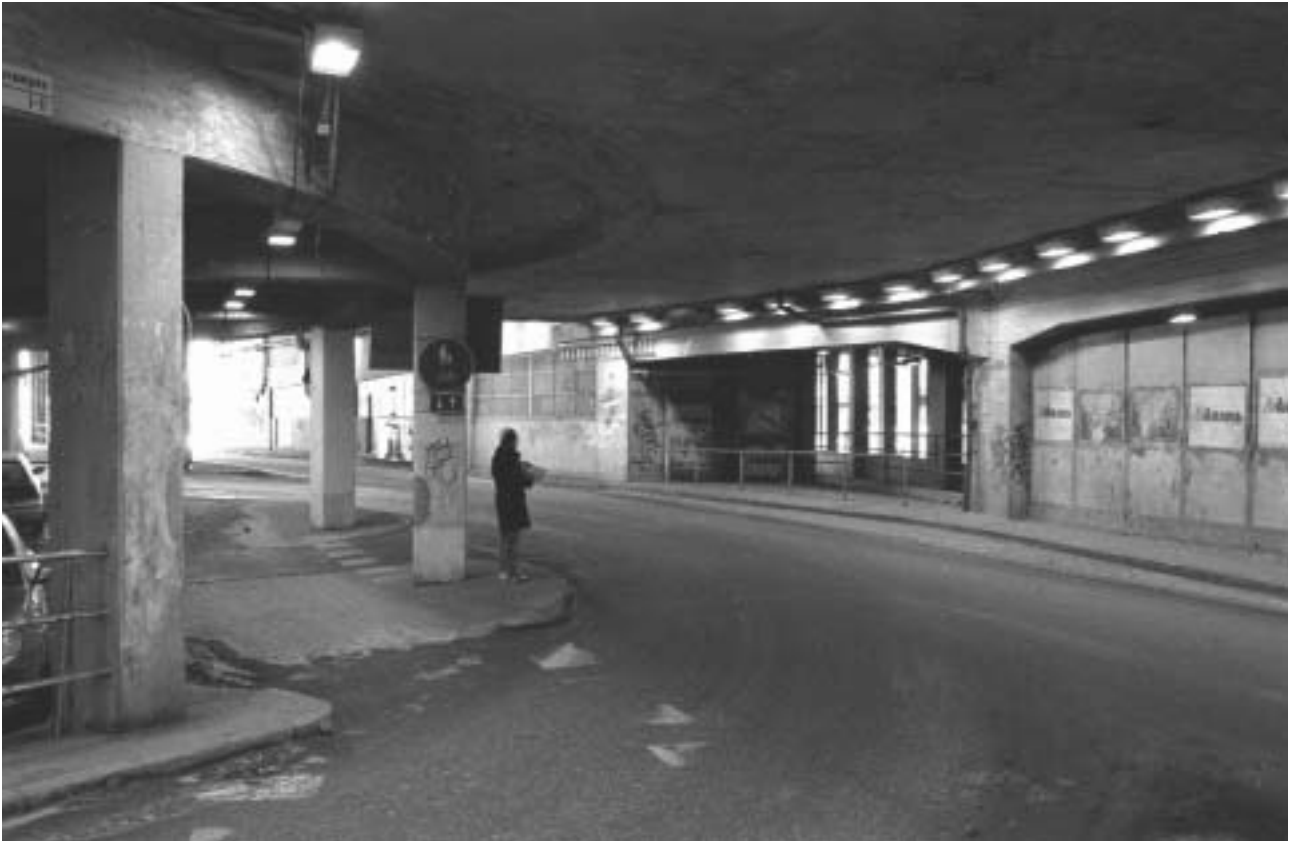
Nytaget fotografi från Norra Järngraven, mot öster. I de underjordiska gatusträckningarna är 1930-talskaraktären ofta välbevarad, här kan man notera det ursprungliga räcket till vänster, man kan även ana den ursprungliga täckmålningen på betongytorna. GFS2005-0011-05.
