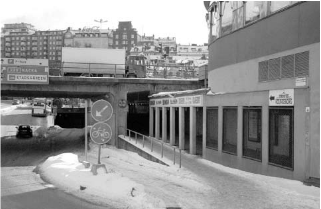
Gula Gången löper i sin norra del under Kolingsborg. Fönsterpartierna i muröppningarna är borttagna. Foto från norr, korsningen Katarinavägen–Västra Slingan. Nytaget foto. GF S2005-0010-27.
