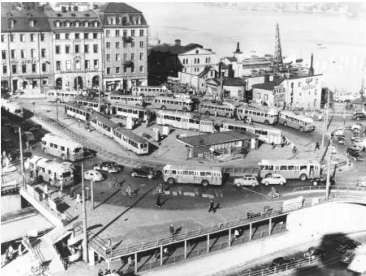
Vy från Katarinahissen över Södermalmstorg en septemberdag 1952. Bilden är tagen strax efter att Holger Bloms sommarservering ovan Gula Gängen revs. Spiraltrappan i stål vid Ryssgården finns kvar och i markplan syns den rivna byggnadens plats som en mörk fläck på markbeläggningen. SSMA Fa 6339.
