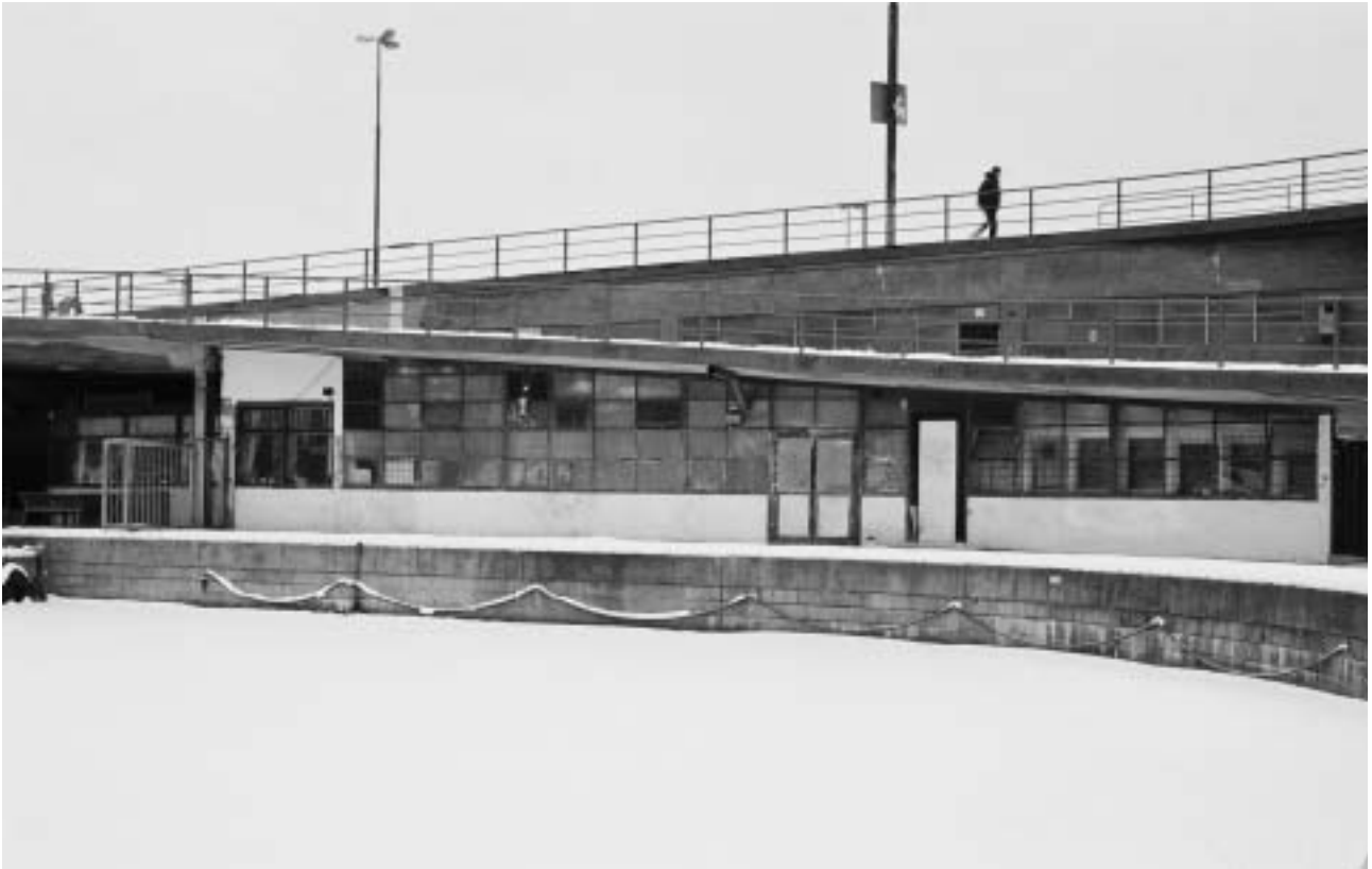
Fasad under Mälarrampen, mot väster, nytaget fotografi. Till höger i bild syns träfönstren vid det f.d. Slusskontoret. I övrigt vetter fönstren mot den f.d. målarverkstaden m.m. som idag rymmer lokaler för en motorcykelklubb. I bildens övre del syns Mälarrampen och bakomliggande fasad som hör till en f.d. bilverkstad (nu garage). GF SF05-0007-23A.
