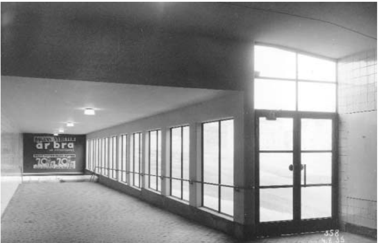
De ursprungliga fönsterpartierna ut mot Katarinavägen i gångens nordliga del. Fotografi från 1935. SSMA Fa 50847.
