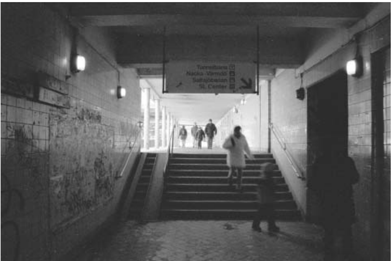
I gången finns två inre trappor. Nytaget foto mot norr i gångens mittparti. Till höger öppningen mot trappan till bussterminalen och Saltjöbanans station. GF S2005-0010-19.
