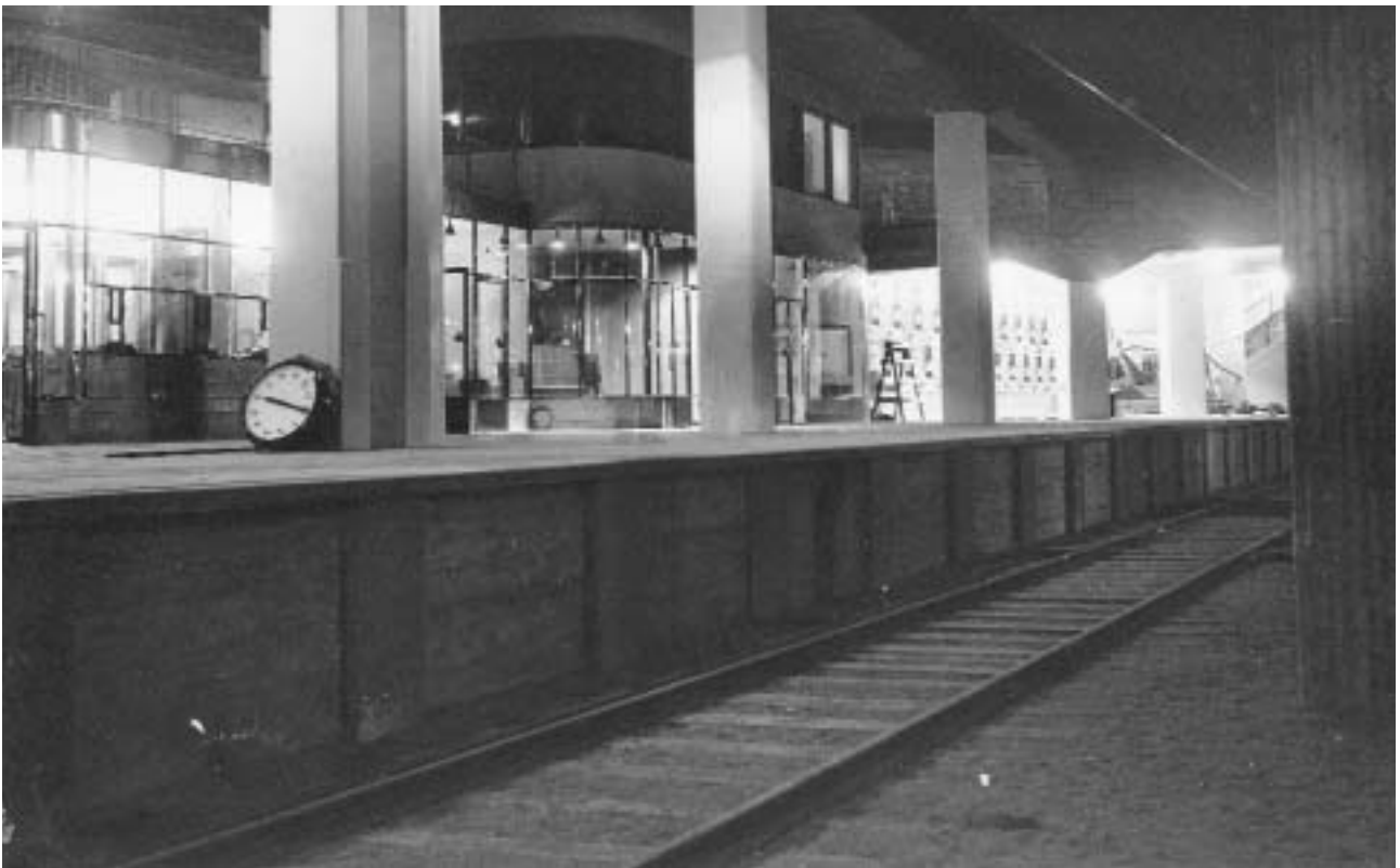
Saltsjöbanans stationsanläggning med spår och perrong i förgrunden. I bakgrunden stationshuset med blänkande nya stålpartier. Stationens klocka är ännu inte uppsatt. Stationen invigdes inte förrän 1936. SSMA Fa 50844.
