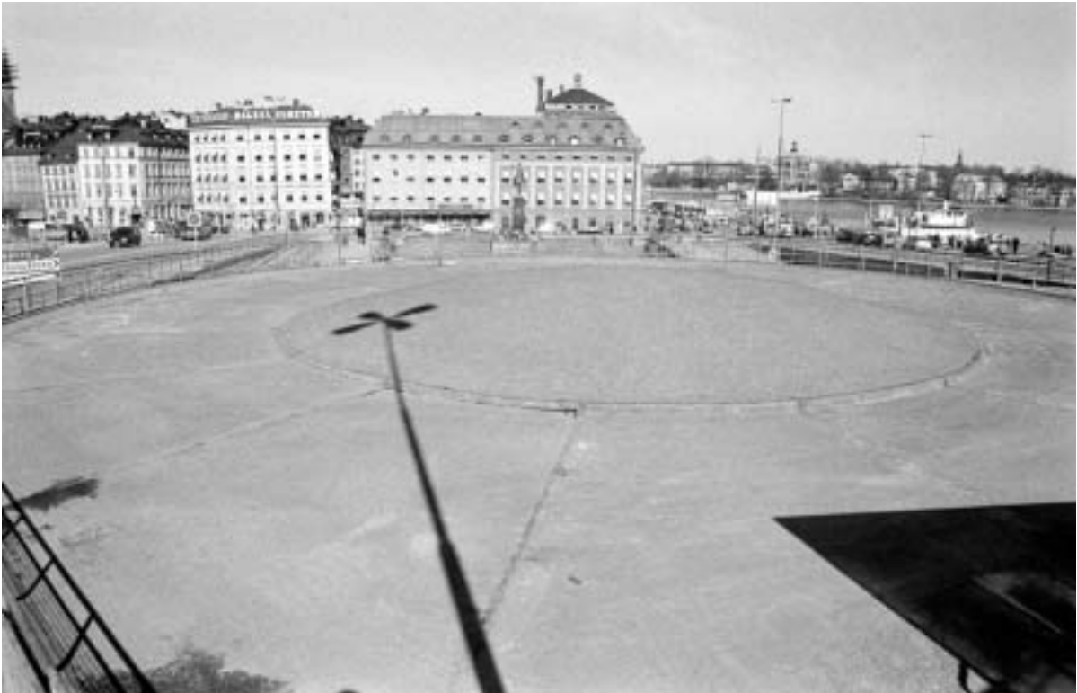
Nytagen vy mot norr över platsen på Blå Bodarnas tak. Kupolen övertäckt med asfalt, det ursprungliga räcket runtom den är borttaget. GF S2005-0040-06A.
