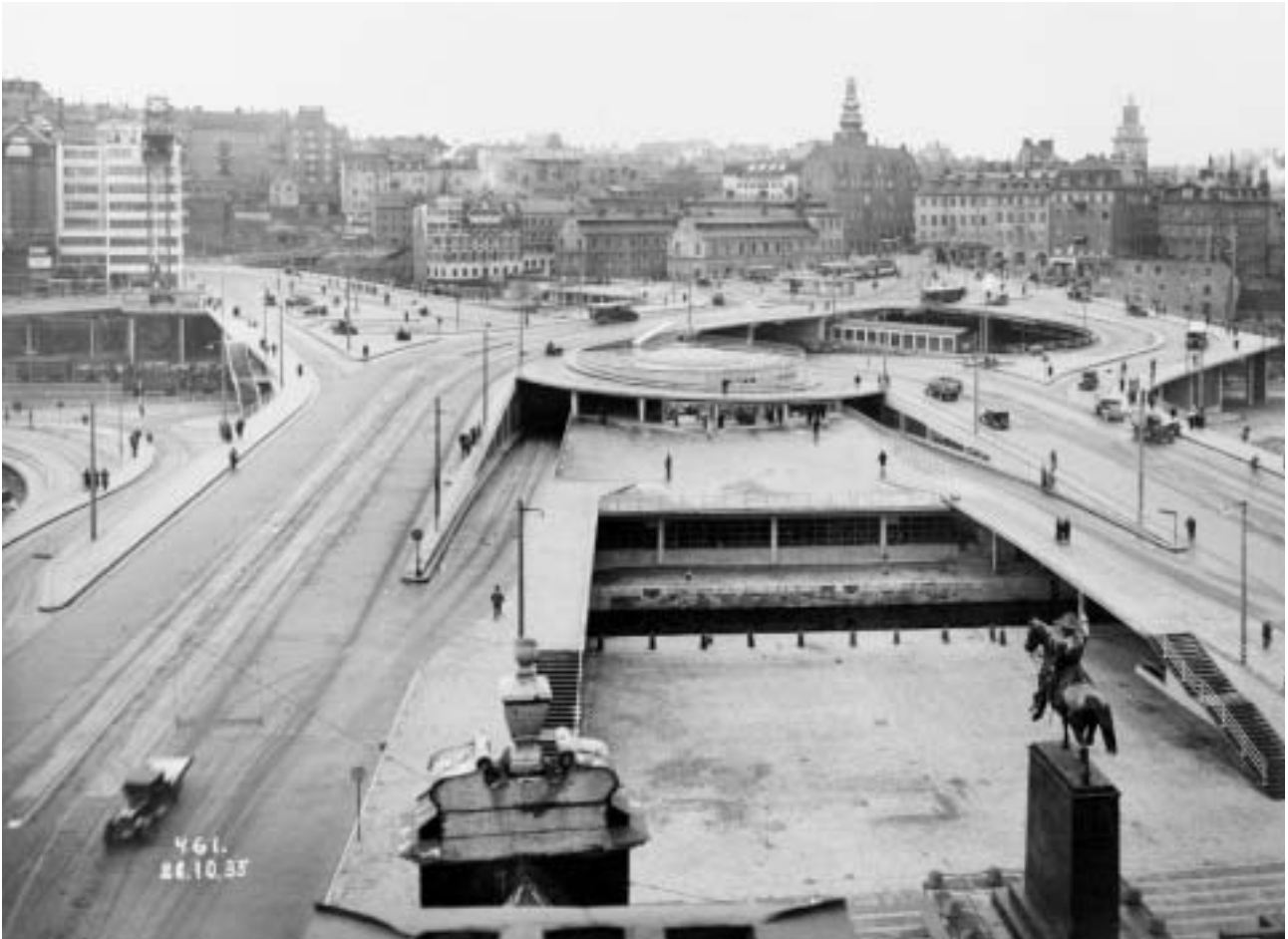
Karl Johans torg och Slussenterrassen ligger symmetriskt inplacerade mellan bro- och vägbanor. Blå Bodarnas kupoltak utgör ett samlande nav i anläggningens mitt. Söder om Blå Bodarna är trafikapparaten asymmetriskt utlagd med Södra och Norra Slingan, Södermalmstorg och tunnelbanestationen. Foto från 1935. SSMA Fa 50840.
