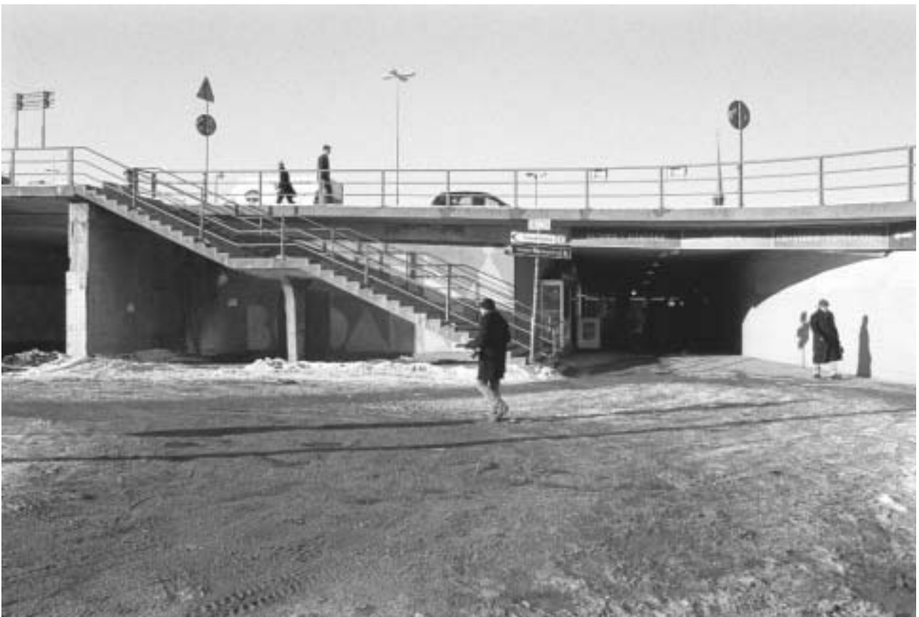
Blå Bodarnas södra entré, nytaget foto från Södra Slingan. De ursprungliga skyltfönstren i smäcker anodiserad aluminium är borta, ersatta av en murad och putsad vägg. GF S2005-0020-18A.
