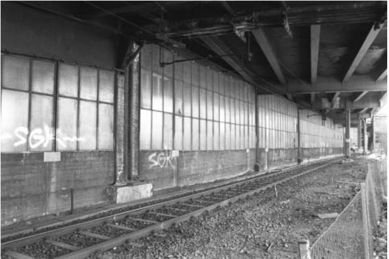
Byggnadskroppens fasad mot norr ligger invid Saltsjöbanans spår och under Saltsjöutfartsrampen. Fasadens stålfönsterpartier är smäckra och mycket välbevarade. Nytaget foto. GF S2005-0027-08
