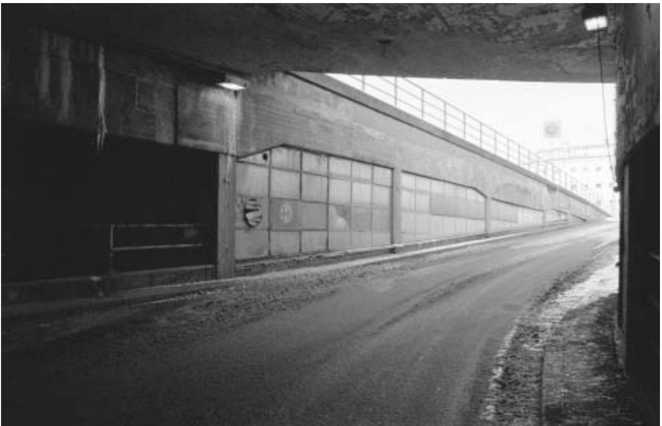
Bevarade fönsterpartier med platta profiler av stål infattade mellan bärande pelare med voter samt bjälklag. Västra Terrassrampen mot norr. GF S2005-0011-07.
