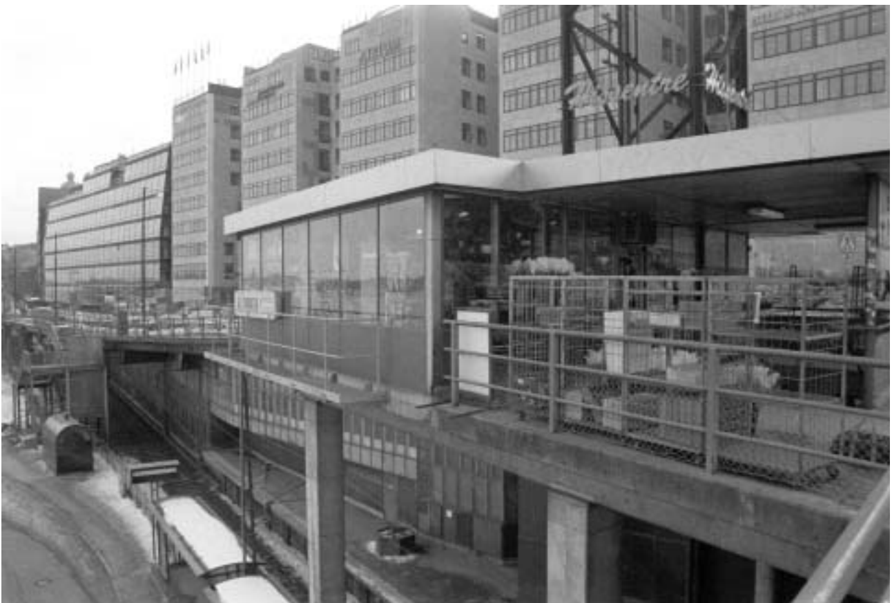
Kioskbyggnaden vilar på pelare vid Saltsjöbanans station. Fasad mot norr. GF S2005-0034-30A.
