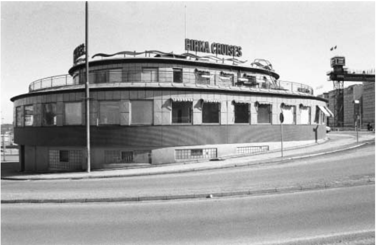
Nytaget exteriörfotografi över fasaden mot väster. Ursprunglig fasadbeklädnad i ljusblå emaljplåtar. Mosaikbeklädnaden under togs ned år 2000 och ersattes med ny i likartat utförande. GF S2005-0040-35A.
