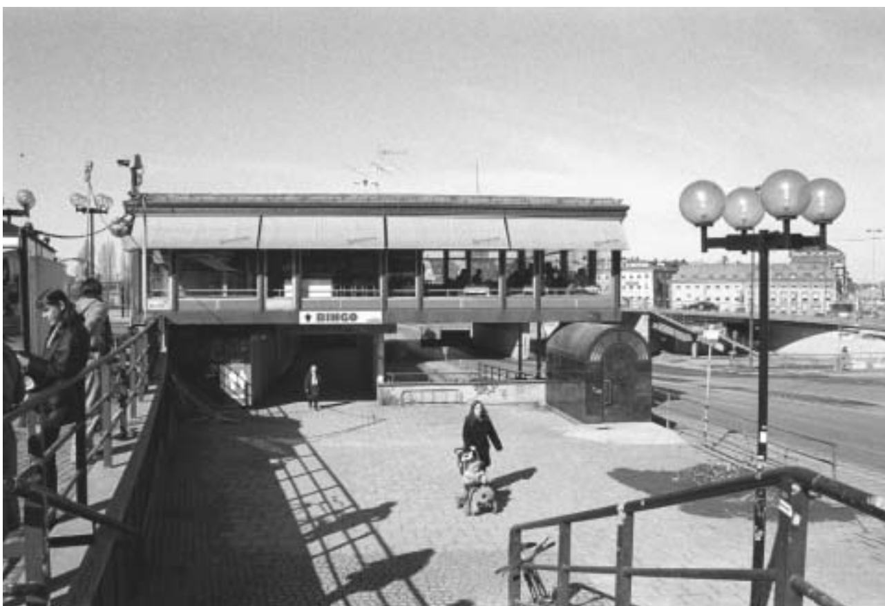
Restaurangbyggnaden vilar på stälpelare över Gula Gångens sydligaste del. Nytaget foto. GFS2005-0041-21A.
