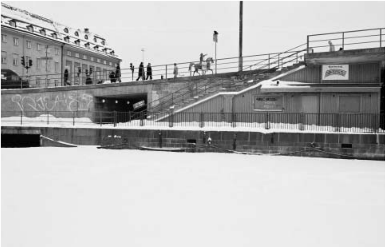
Nytaget fotografi över fasaden mot väster, med Gröna Gångens mynning och trappan till Katarinavägen. Till vänster skymtar avtappningskanalens västra mynning. GF SF05-0008-10A.
