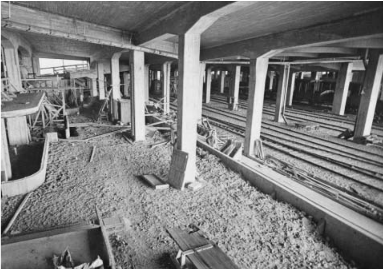
Fotografi från 1930-talet, som visar Saltsjöbanans stationsanläggning under uppförande. Till vänster ser man Stationshusets ytterväggar, innan glasfasaderna kommit på plats. Till höger den blivande hamnbangården. SSMA Fa 50834.
