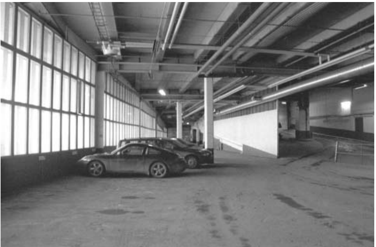
Det stora utrymmet i öster fungerar idag som garage och in/utlastningszon. GF S2005-0030-06.
