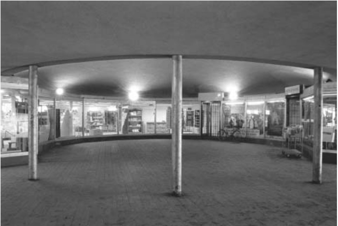
Kupolrummet, med sin krans av stälpelare. Glasbetongkupolen är överputsad, alla skyltfönster är sekundära. Nytaget fotografi. GF. S2005-0018-22A.
