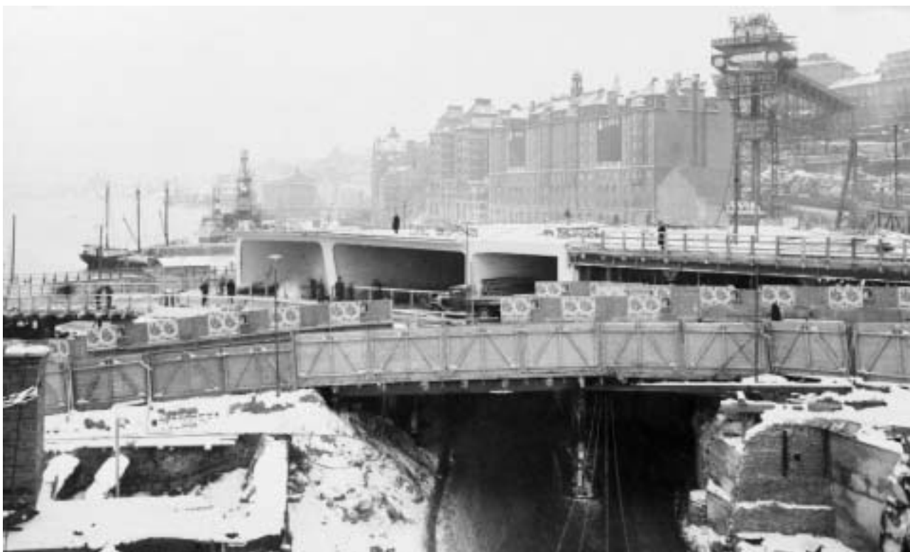
Viadukten för den planskilda korsningen i anläggningens centrum under uppbyggnad. SSMA Fa 50833.
