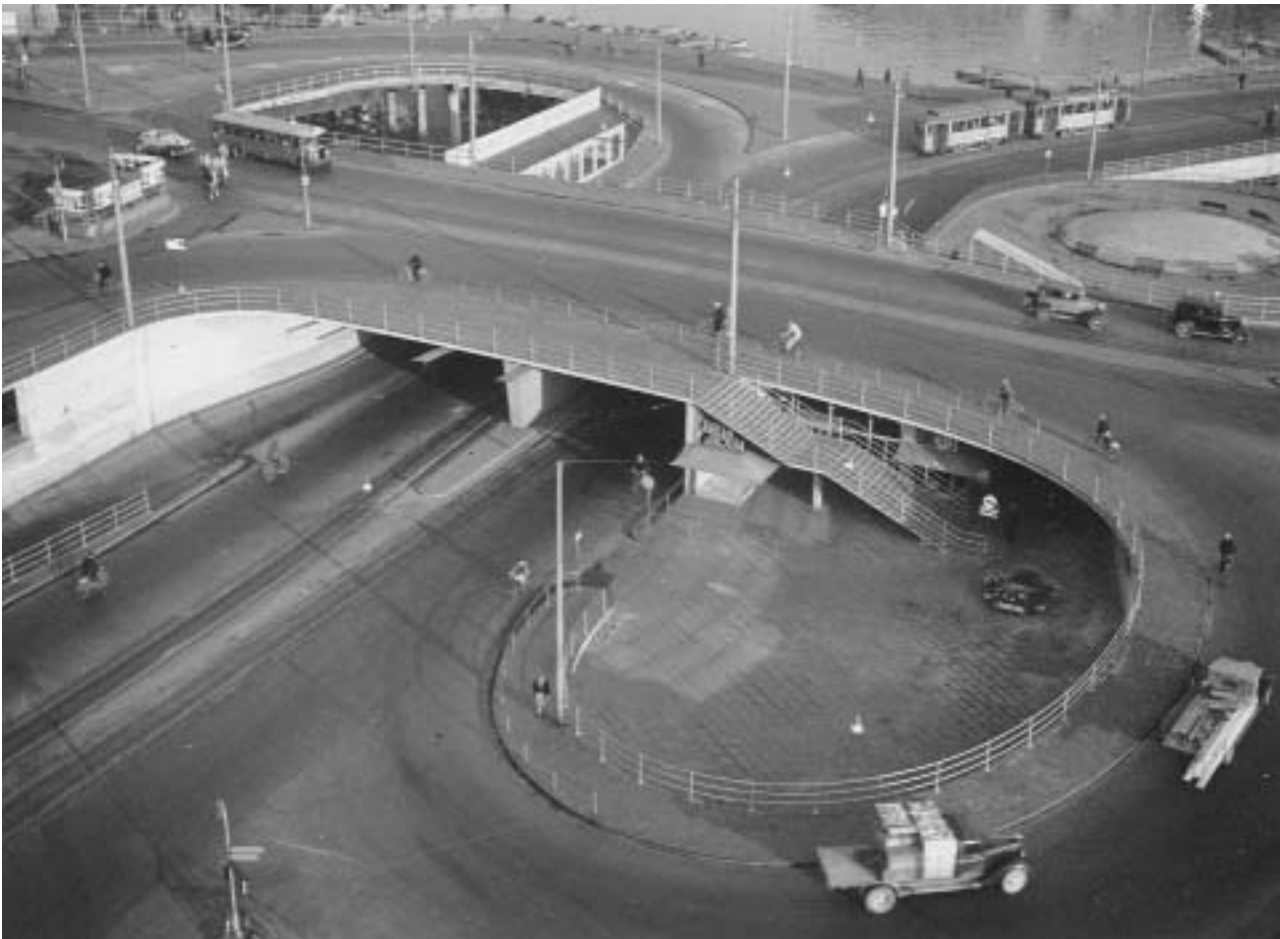
Blå Bodarnas södra entré som den tedde sig på 1930-talet. Framför entrén den karaktäristiska trappan som förbinder platsen i Södra slingan med Skeppsbron. I bildens övre del skimtar den del av Gula Gången som fram till uppförandet av Kolingsborg var inbyggd i en långsmal byggnadsvolym med glasade muröppningar mot öster. SSMA Fa 50845.
