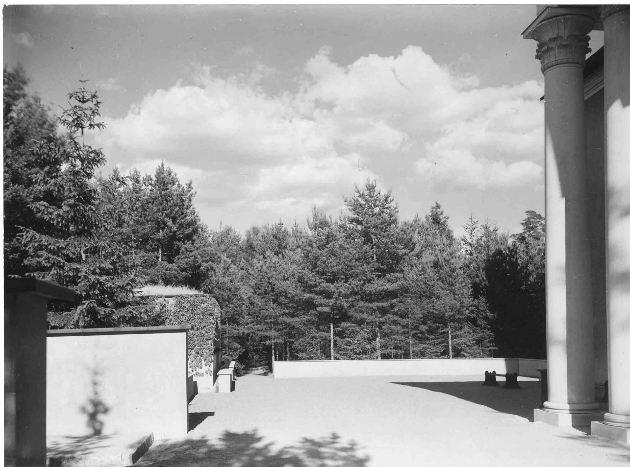
Uppståndelsekapellet's gård. T.v. skimtar väntrumbyggnaden med sitt ursprungliga grästak. Odaterat foto från väster.
