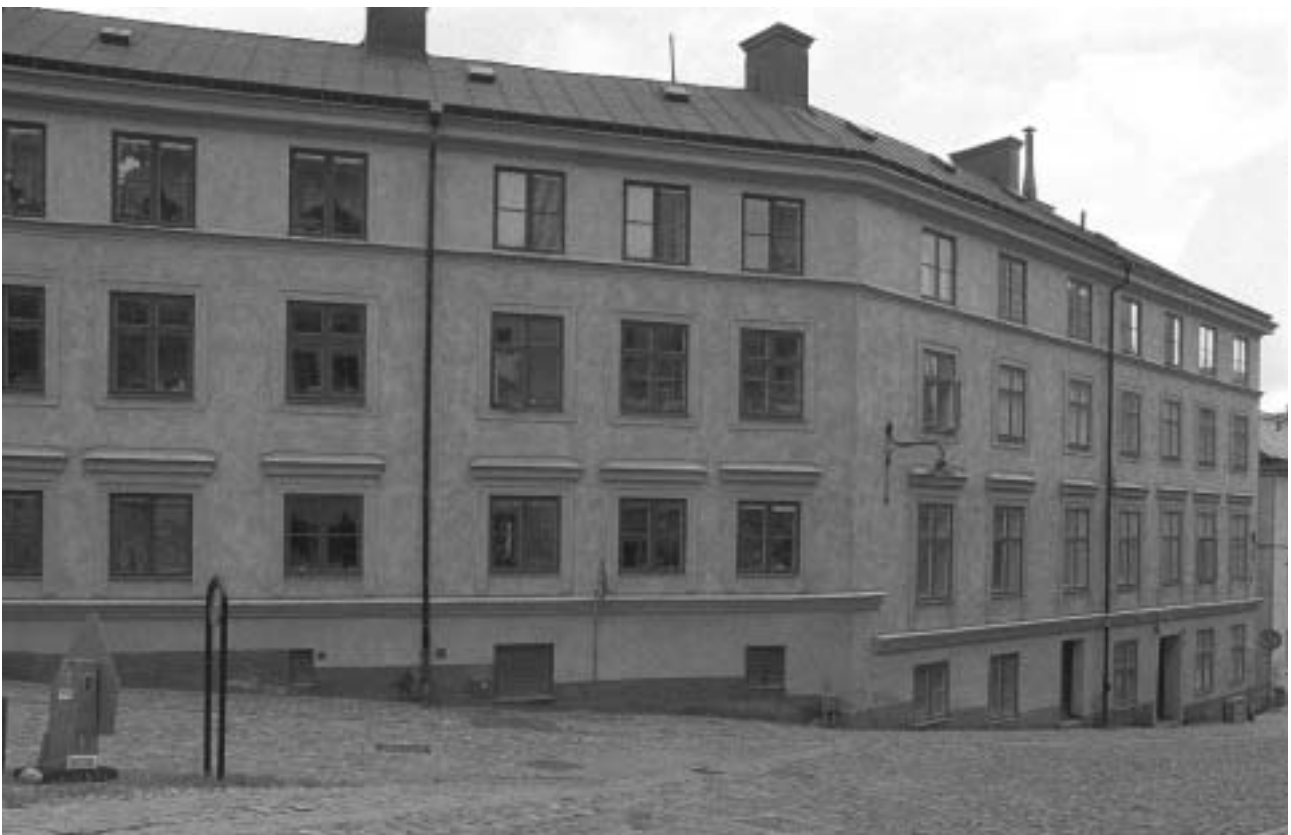
Mot nordöst. Bastugatan 6. Till höger gatuhuset med entré från gatan. Till vänster det södra gårdshuset med entré endast från gården. Dessa två byggnadskroppar har givits samma fasaddekor under åren 1858–1861. IJ S2004-0103-35
