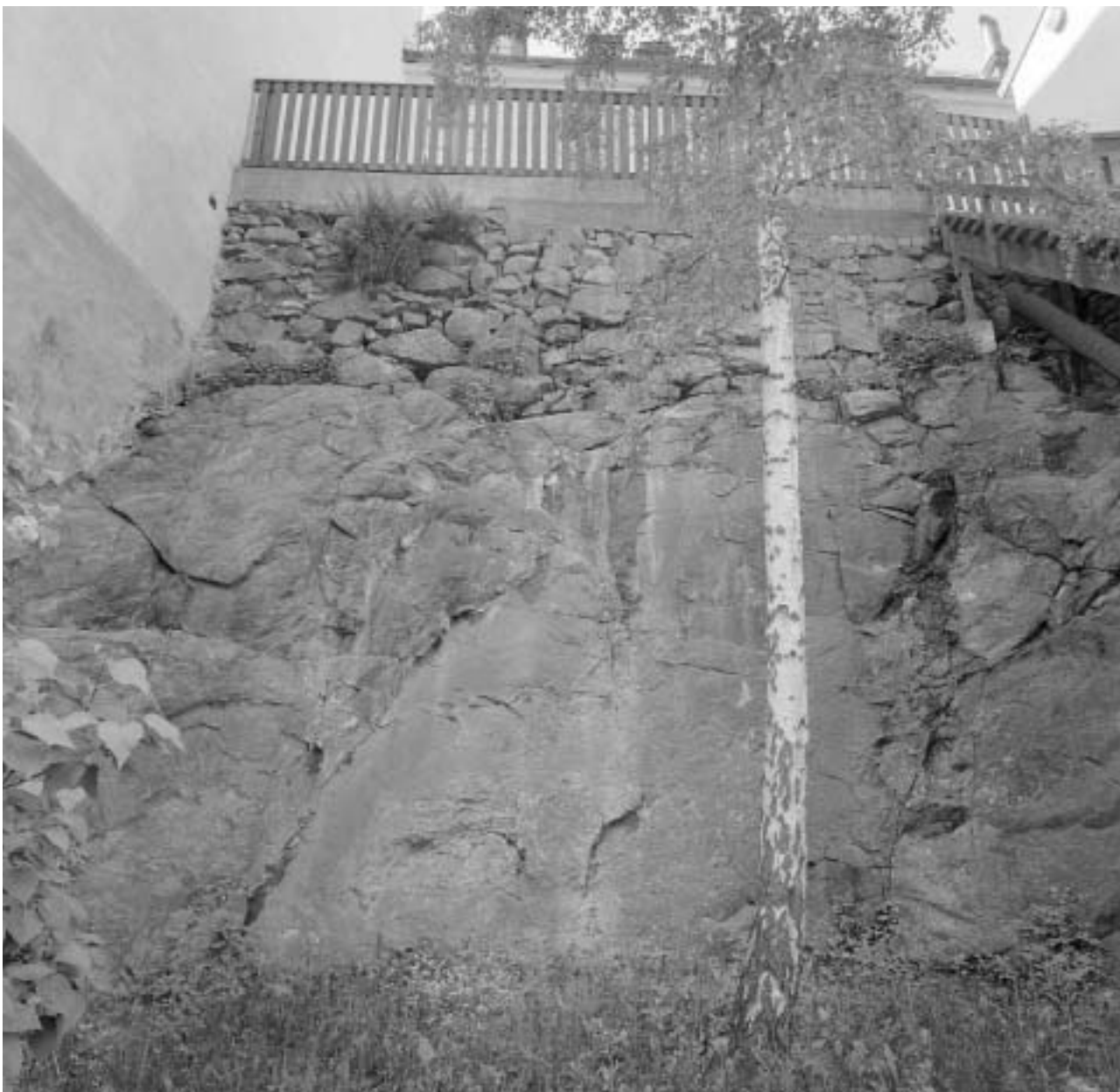
Söder Mälarstrand 17, Pryssgränd 8. Mot söder och gården. Gårdens beläggning vilar på en kallmurad sockel som är murad direkt på berget. På detta sätt är även gården vid Pryssgränd 10 A och B uppförd. IJ S2004-0091-10
