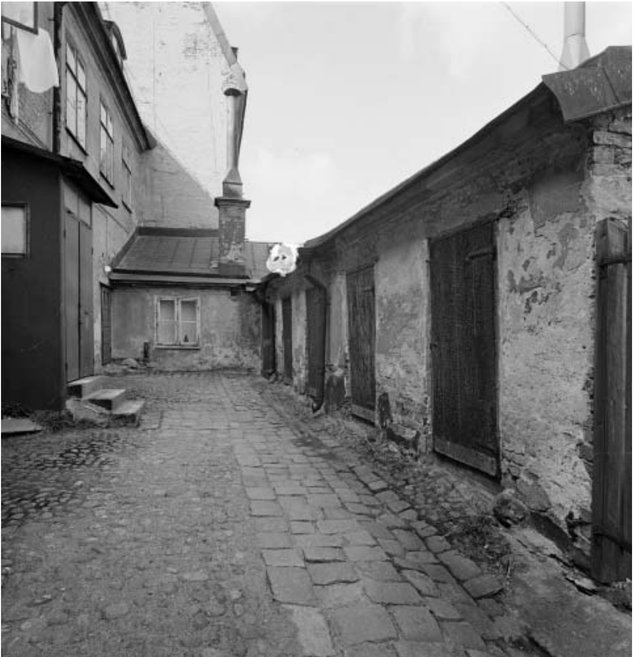
Gården vid Pryssgränd 8, innan renoveringen. Fotograf: G. Fredriksson. SSM, F99136
