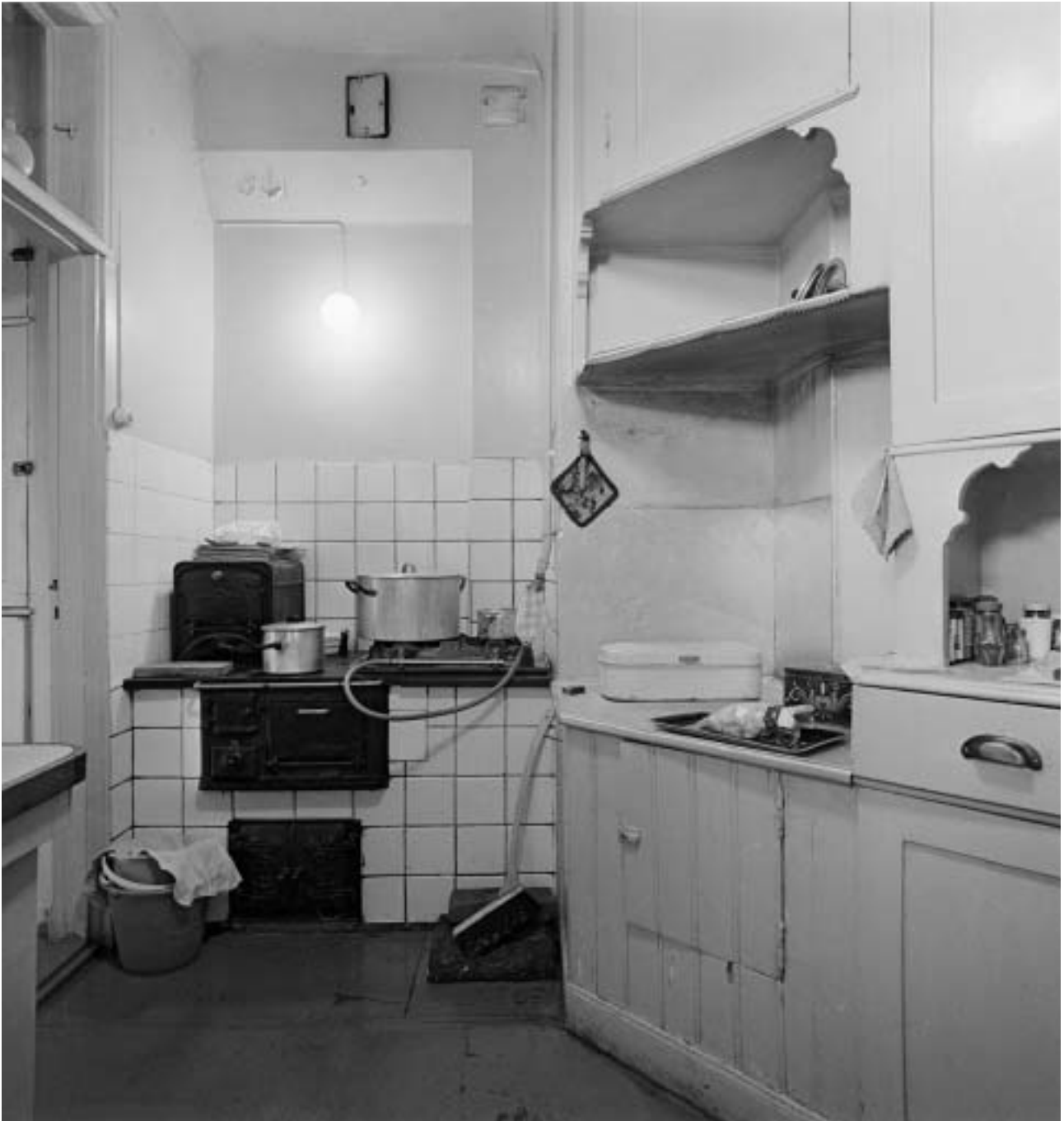
Bild 25. Kök vid Bastugatan 6, 2tr, innan renoveringen genomfördes. Fotograf: G. Fredriksson. SSM, F99100
