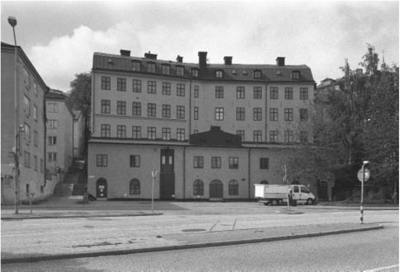
Bostadshuset på Bastugatan 6 samt verkstadshuset på Södermälärstrand 15 mot norr. IJ S2004-0103-10
