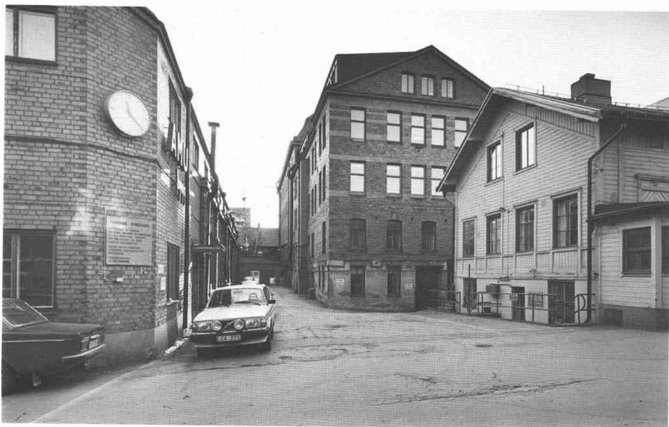
Anläggningens gård mot söder. T h portvaktsbostaden (III). Foto 1983. S83-0066-12.
