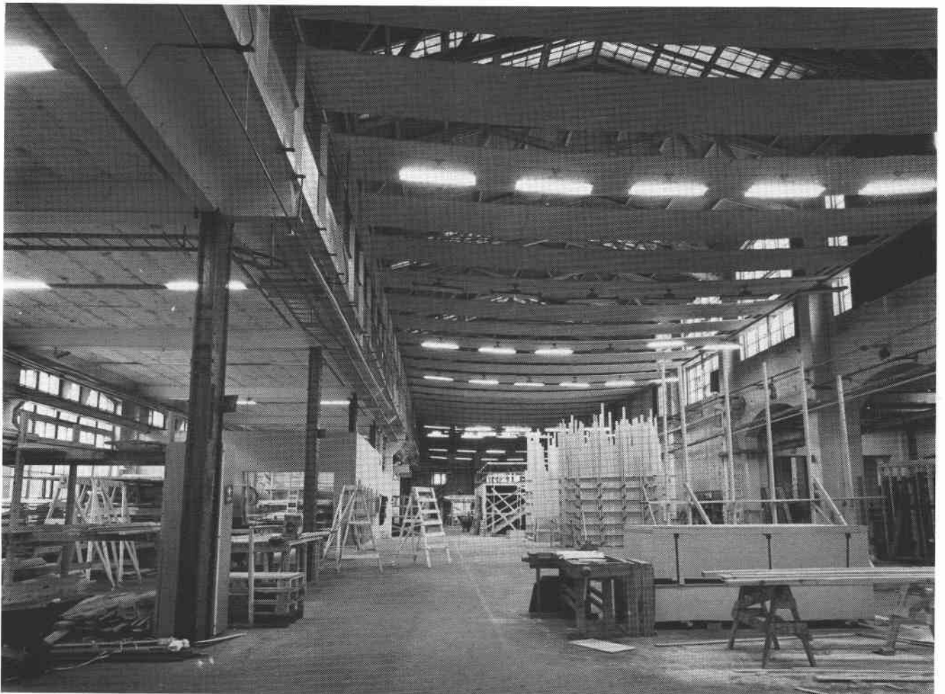
Interiör från maskinhallen (VIIb). S82-0408-5.
