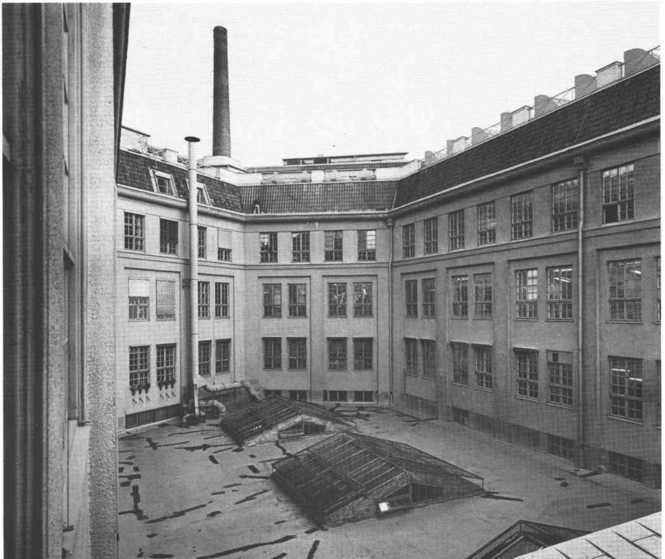
Fabrikens (I) överbyggda gård. S82-0499-2.
