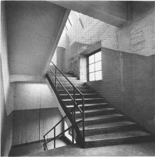
Trapphus i magasinsbyggnaden (I). S82-0407-5.
