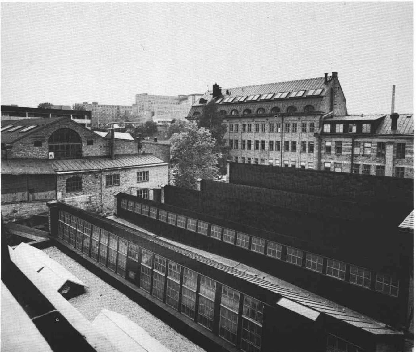
Den ursprungliga verkstadsbyggnadens sågtak. Där bakom plåtslagareverkstaden och kontorshuset. S82-0409-2.
