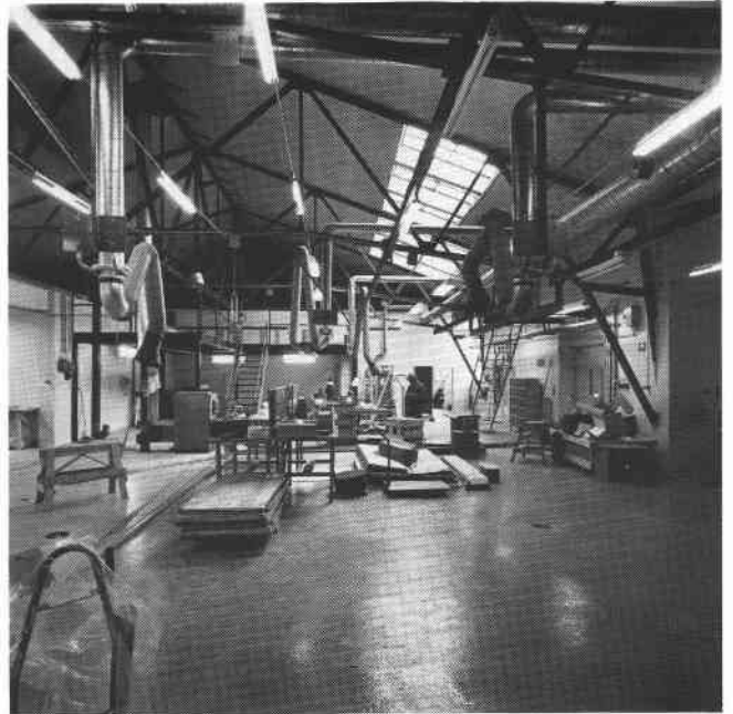
Interiör från verkstaden (VIIc). Tak- våningen. S82-0409-1.
