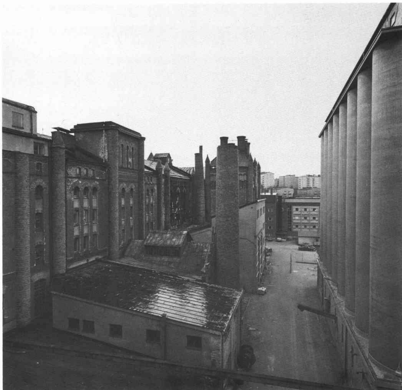
Bryggeribyggnadens sjöfasad. Till höger silobyggnaden. S82-0520-9.
