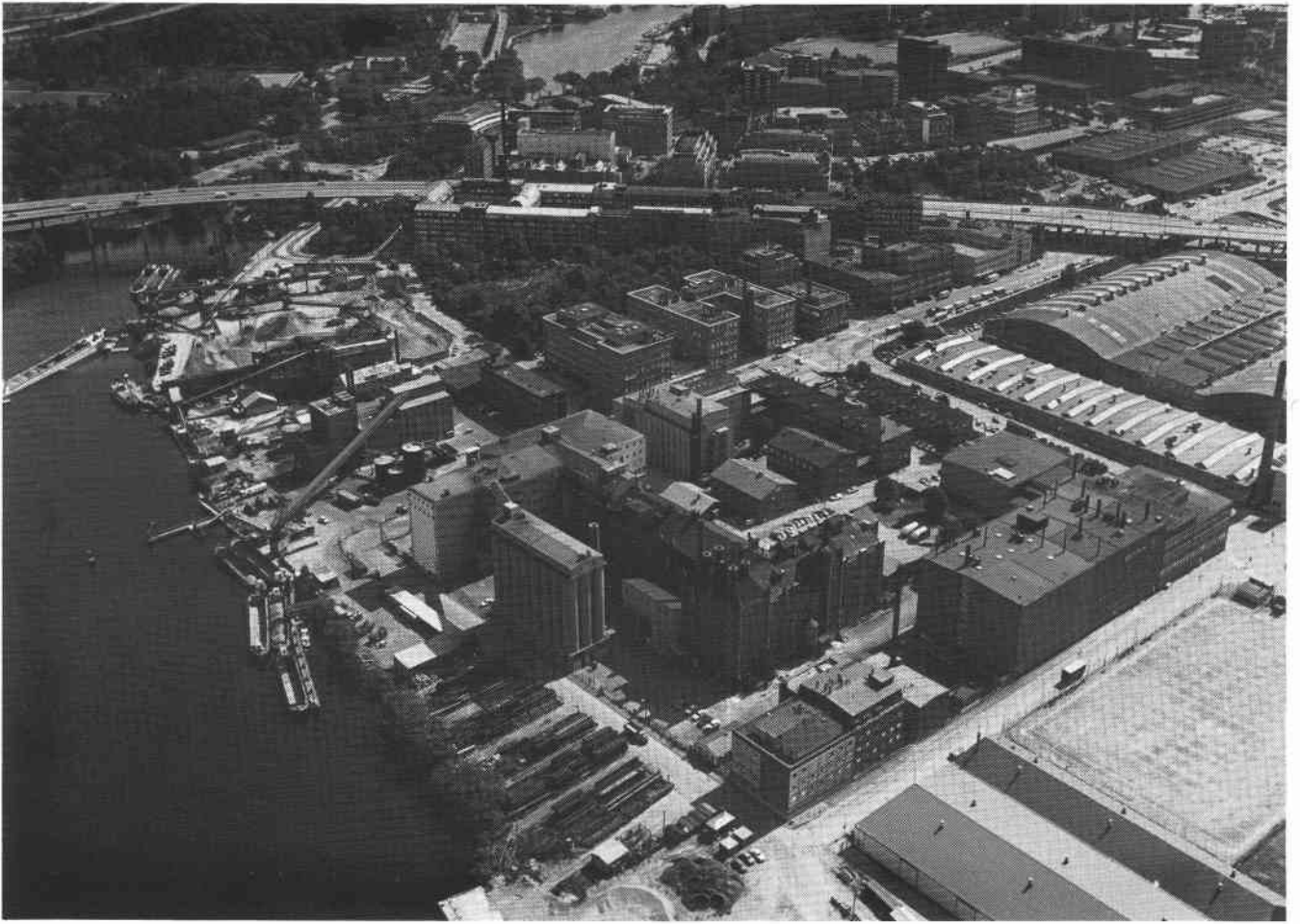
Anläggningen från väster. Foto 1980. FB 14838.
