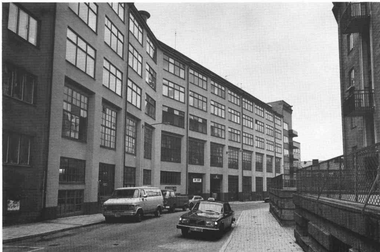
Hus I vid Svarvaregatan. S82-0432-3.
