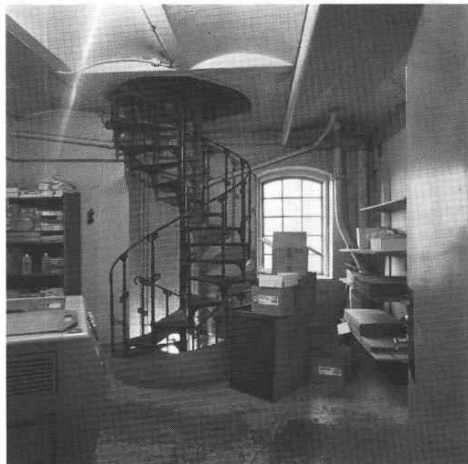
Spiraltrappa av gjutjärn (Ia).S82-0521-4.
