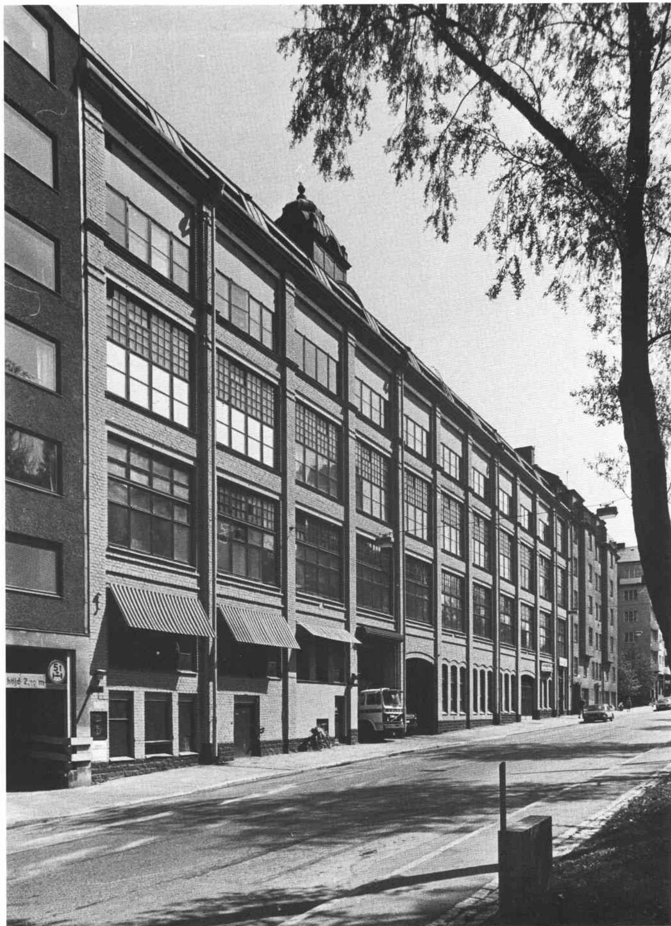
Hus II vid Igeldammsgatan. Fasadutformningen från 1914 är i allt väsentligt bevarad, se s 220. 1979, FB 14717.
