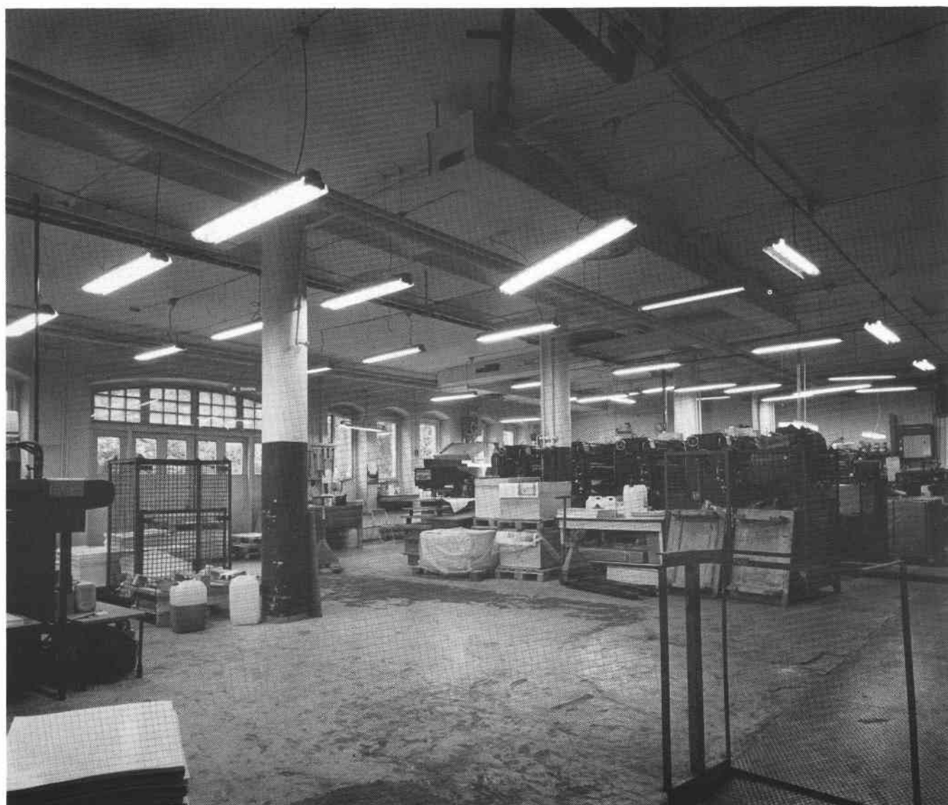
Tryckerilokal på bottenvåningen i hus II. S82-0431-1.
