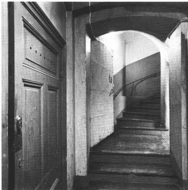
Trapphus i hus C. Göran Fredriksson, S82-0398-6.
