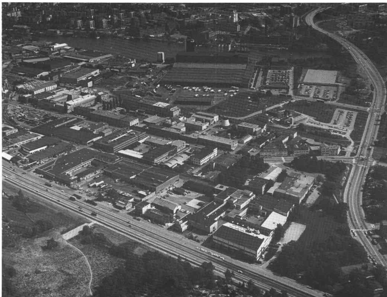
Ulvsunda industriområde från sydväst. I bildens nedre kant, andra anläggningen från höger, Fructus fabriker, 1980. FB 14826.
