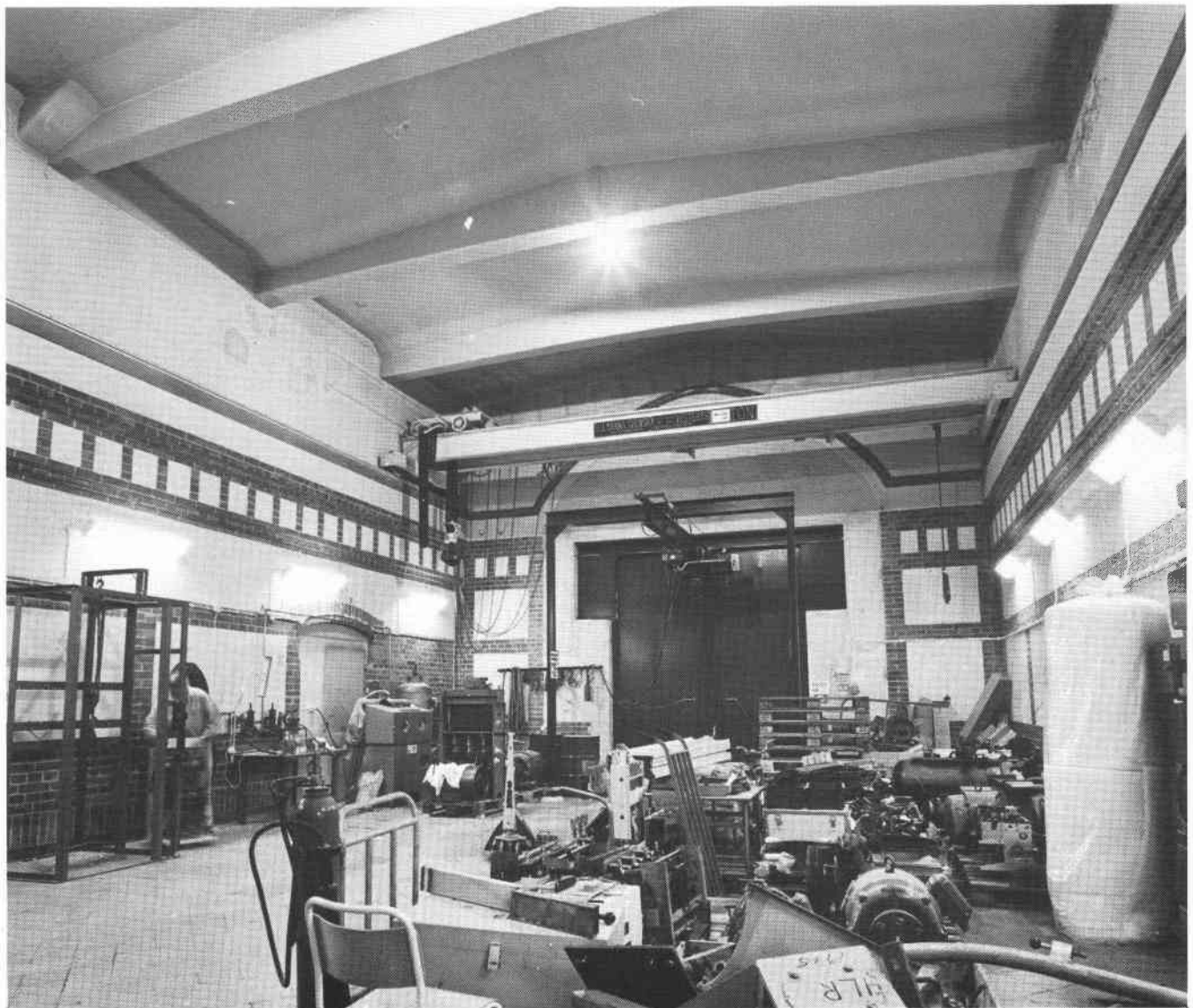
F.d. maskinhallen i hus I med mönstermurade väggpartier. S82-0341-2.
