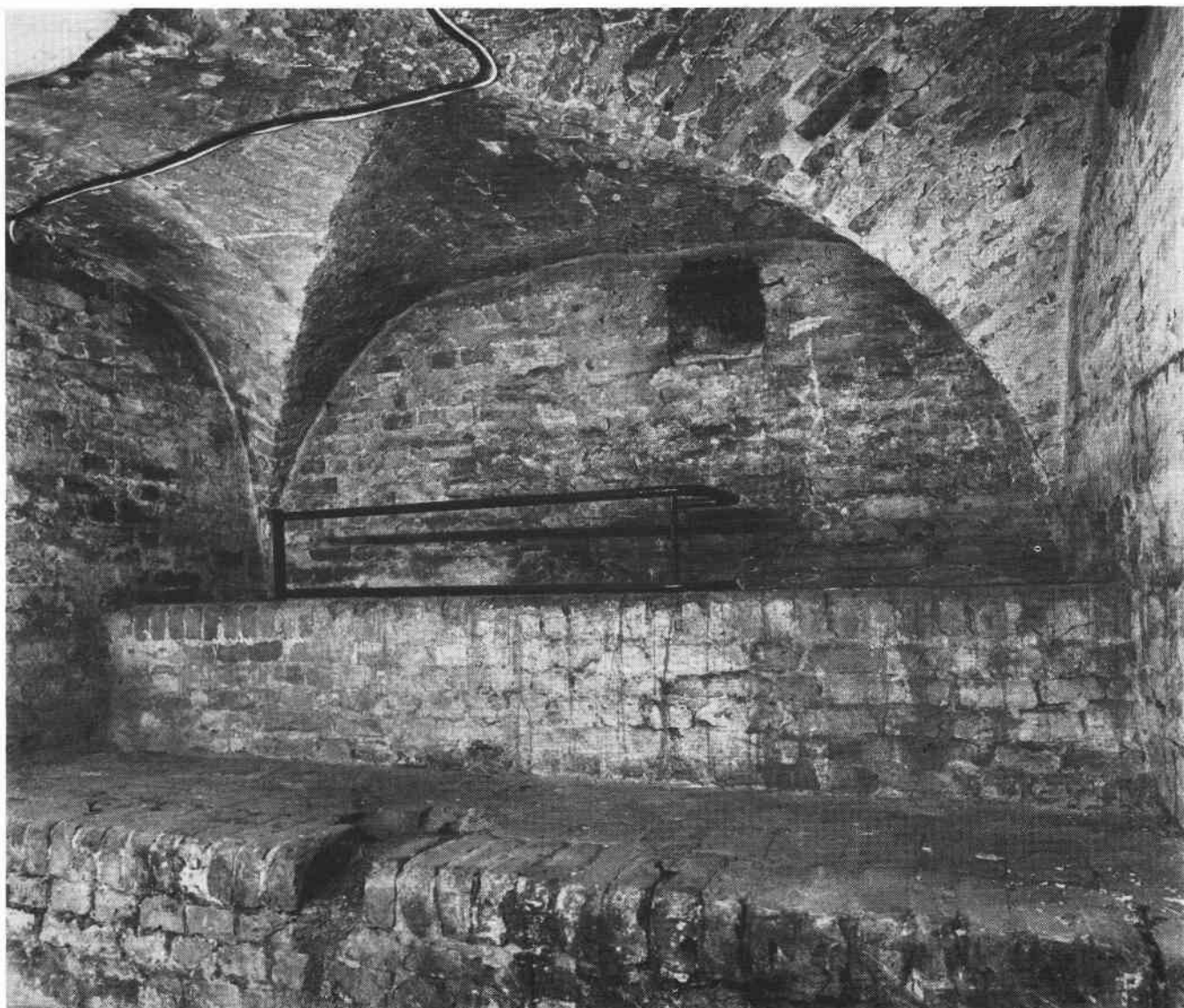
Kryssvälvd källare i hus C. Göran Fredriksson, S82-0398-1.
