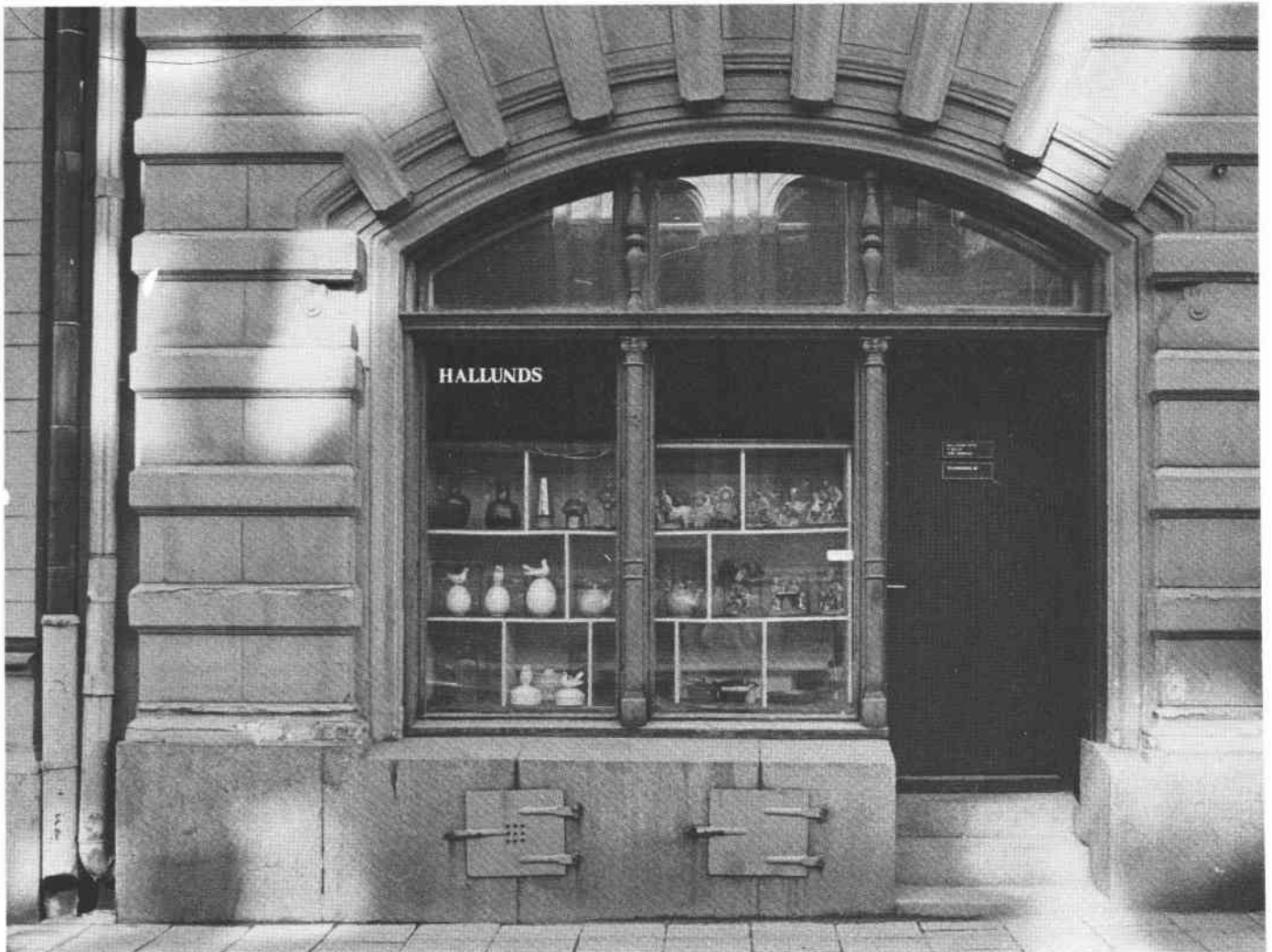
Mjölaren 5, ursprungligt skyltfönster.
