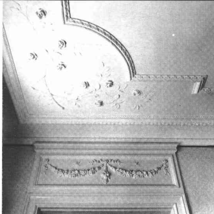
Hälsökällan 8, Tulegatan 29 Dörröverstycke och takdetalj
