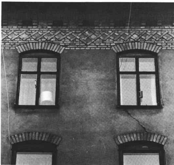
Detalj av taklist i Piskan 6
