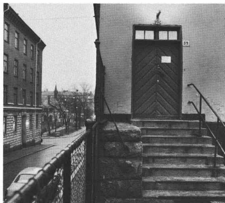
Entré till hus I
