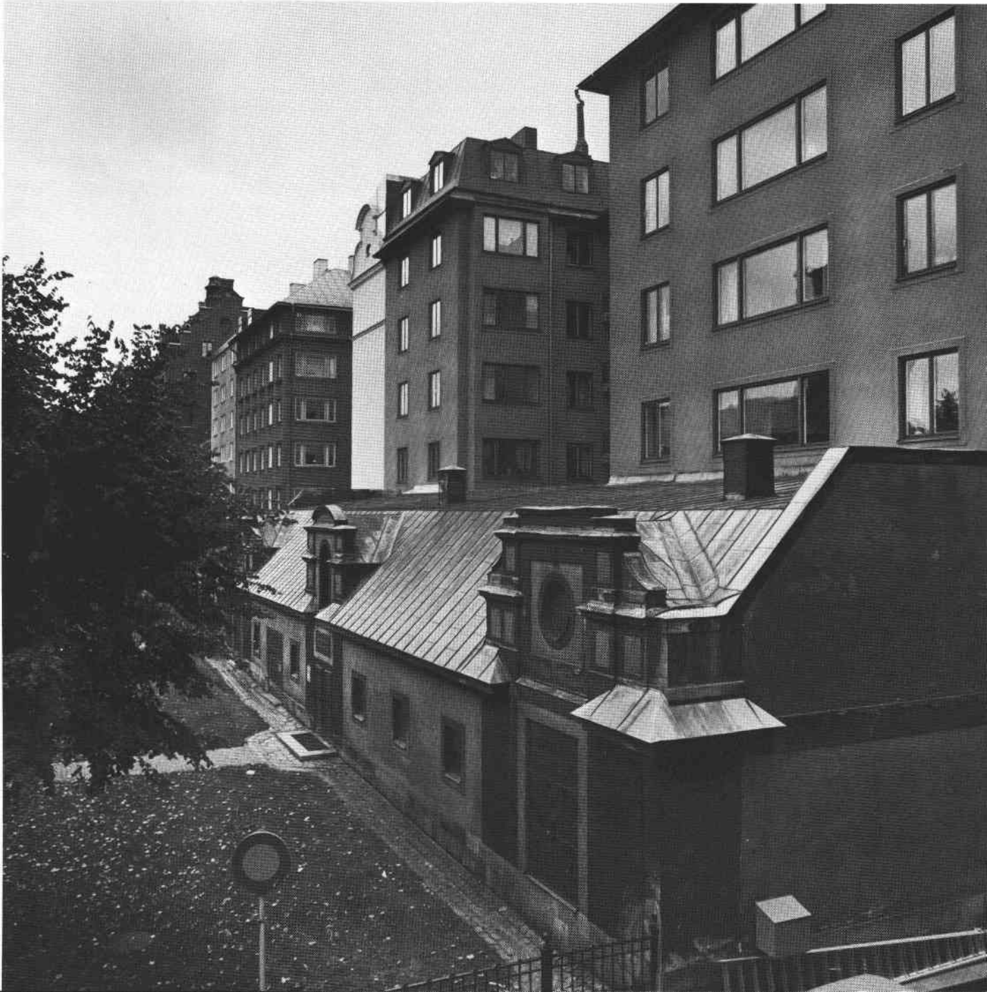
Begravningskapell från 1929, därbakom kv Magdalena
