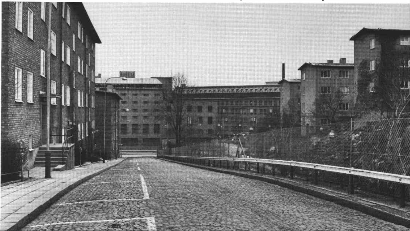
Kv Fyrspannet t v, kv Bergsgruvan Större t h, i bakgrunden Tobaksmonopolet
