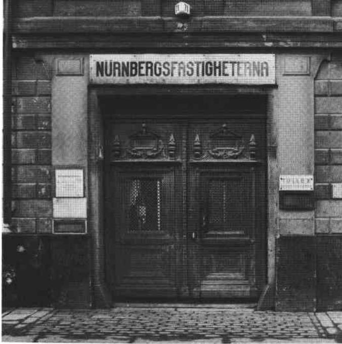
Dykärret Mindre 6, port i hus II
