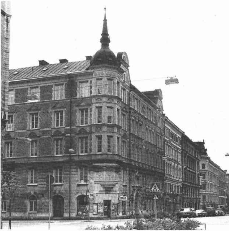
T v: Kv Karl XV:s Port, sett från hörnet Nybrogatan och Östermalmsgatan.
