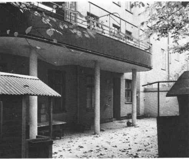
Brandmästaren 24, gård med solaltan.
