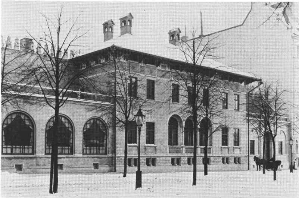
Konsul Broms' villa, Fanan 25, Narvavägen 26-28. Huset uppfördes år 1898-1900 med Ludvig Peterson och Erik Lallerstedt som arkitekter. Bakom de stora välvda fönstren t v låg ursprungligen ett blomsterrum, därovan en terrass. Idag rymmer huset franska ambassaden. Foto 1900.
