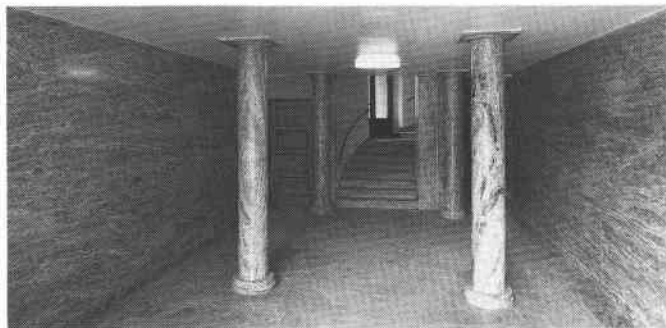
Ovan: Päronträdet 14, port. Tv: Päronträdet 6, entré. Nedan tv: Päronträdet 8, entré. Nedan th: Päronträdet 9, entré.
